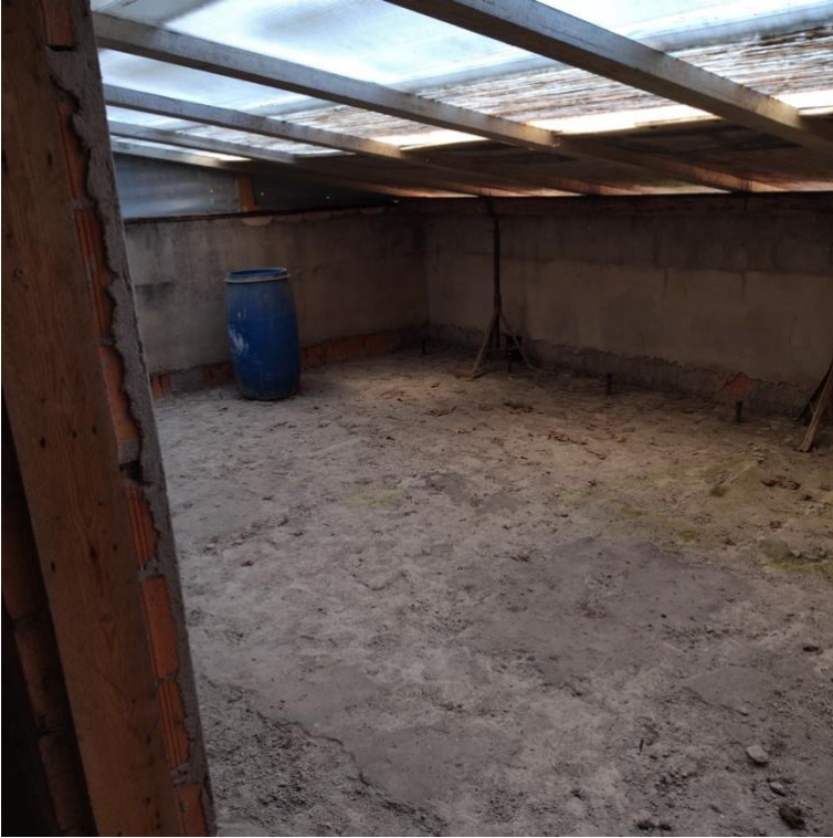
14 lotto 1 - Corpo A terrazza con copertura provvisoria
