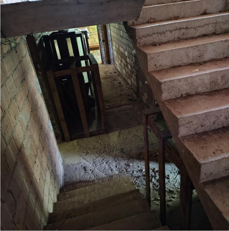
12 lotto 1 corpo A – scala e ingresso al p.t.
