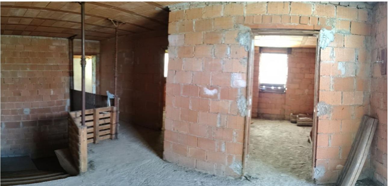
13 lotto 1 - Corpo A piano primo vano scale
