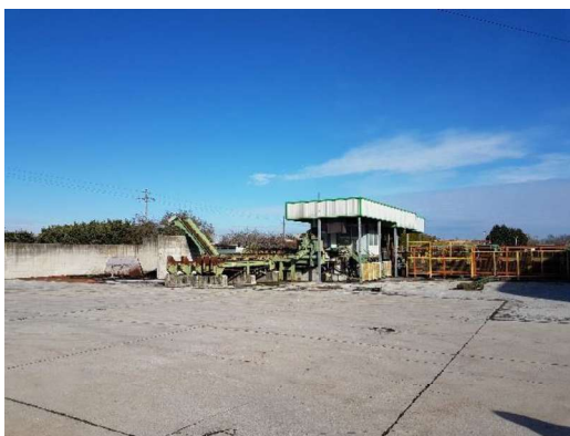
Piazzale area nord ovest
