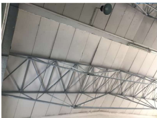
Particolare della copertura
