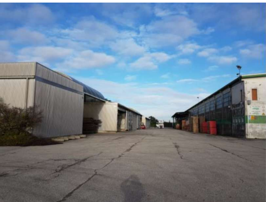
Edifici A (a sx) e B (a dx) da ovest
