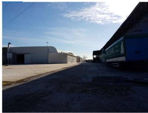
Edifici A e C (da ovest)
