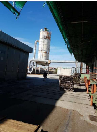
Silos (Edificio E)
