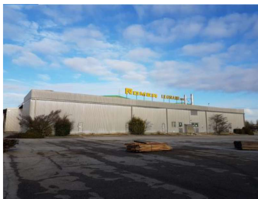
Edificio A visto dalla Romea
