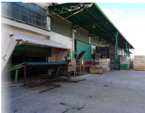
Edificio C lato nord e pensilina C1
