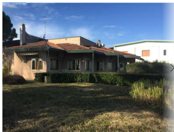
Lato nord est via Romea
