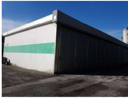
Edificio F – vista del Silos edificio E
