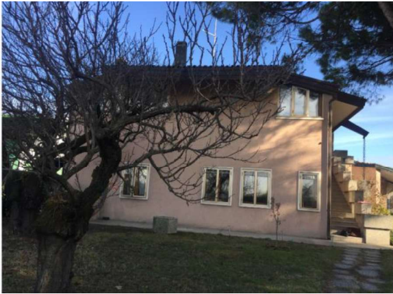
Lato sud est via Onari
