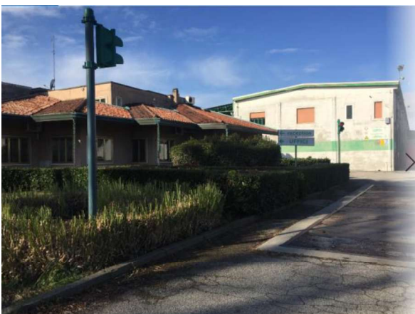
Lato nord interno area
