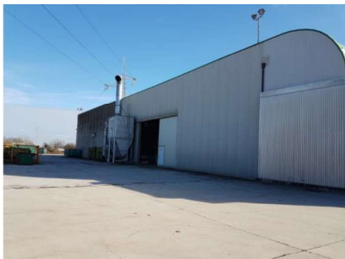
Lato Ovest edificio A
