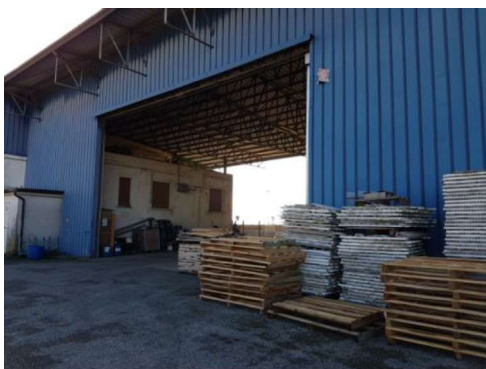
Pensilina tra edificio B ed edifici C e D
