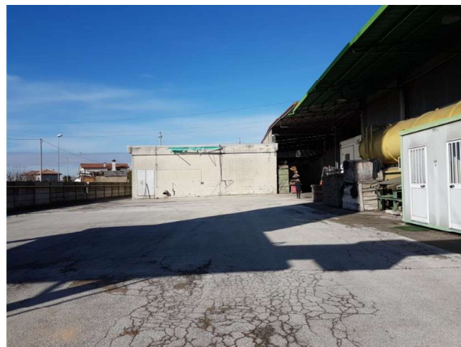
Edificio F (a sx) ed Edificio D (a dx)
