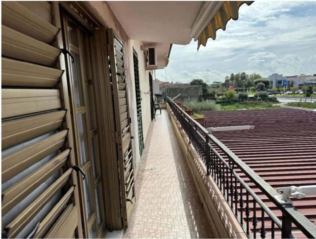
FOTO: BALCONE N°2 DELL'IMMOBILE PIGNORATO
