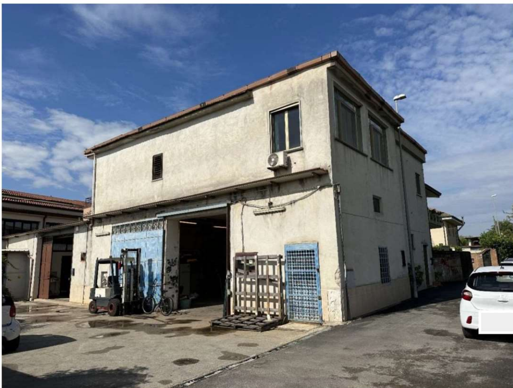
FOTO: FACCIATA PRINCIPALE/LATERALE SX DELL'IMMOBILE PIGNORATO
