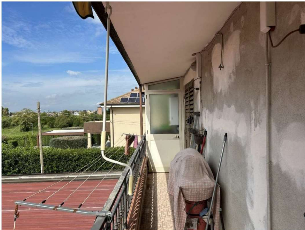
FOTO: VANO RIPOSTIGLIO POSTO SUL BALCONE N°2
