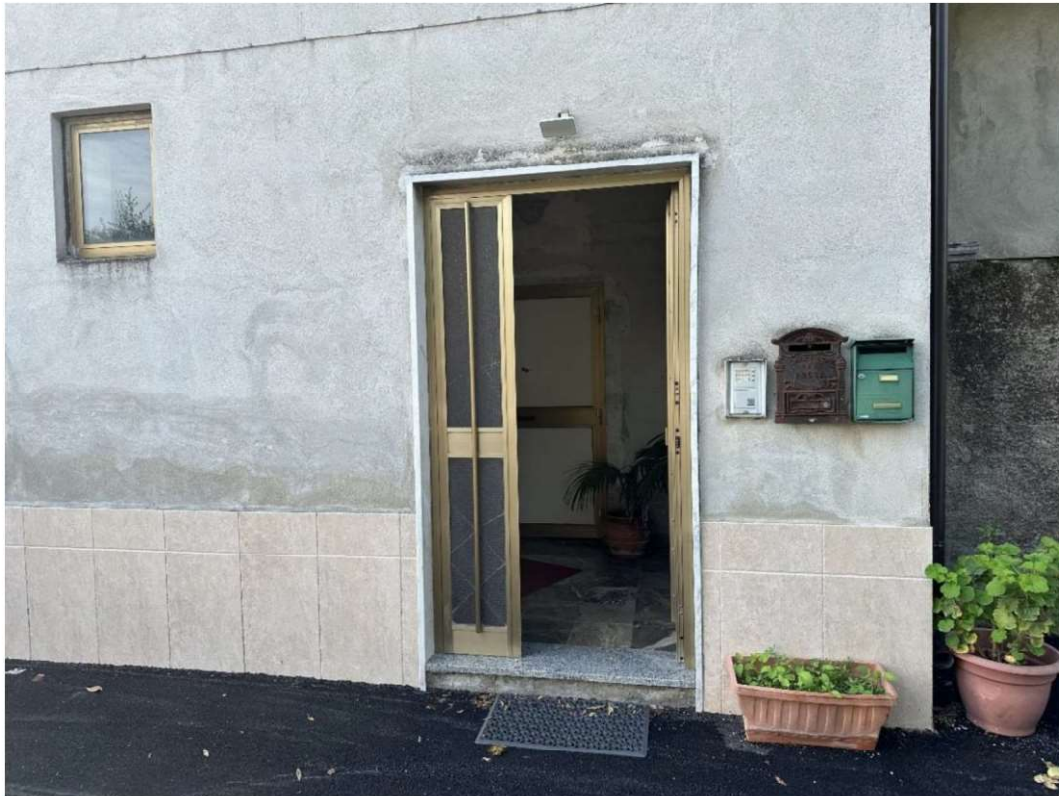
FOTO: PORTONCINO D'INGRESSO PER ACCEDERE ALL'IMMOBILE PIGNORATO
