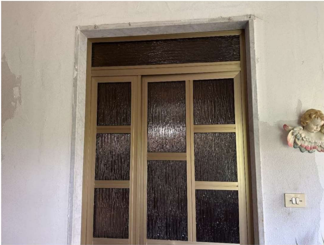
FOTO: PORTA D'INGRESSO PER ACCEDERE ALL'IMMOBILE PIGNORATO UBICATO AL PIANO PRIMO
