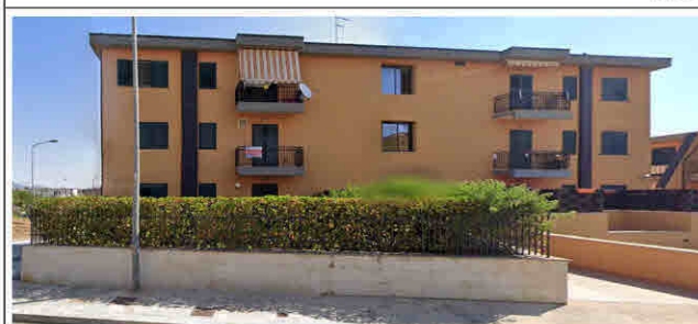
INGRESSO APPARTAMENTO VIA ITALIA 1 A
