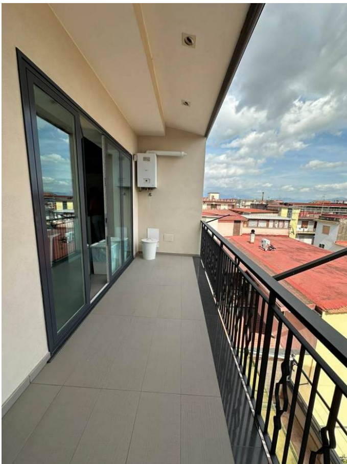
Foto 38 - Il sub 8 – balcone b3
