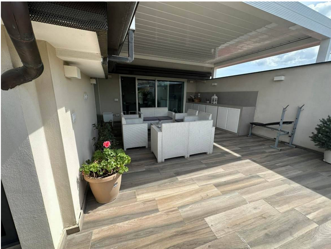
Foto 42 - Il sub 8 – terrazzo
