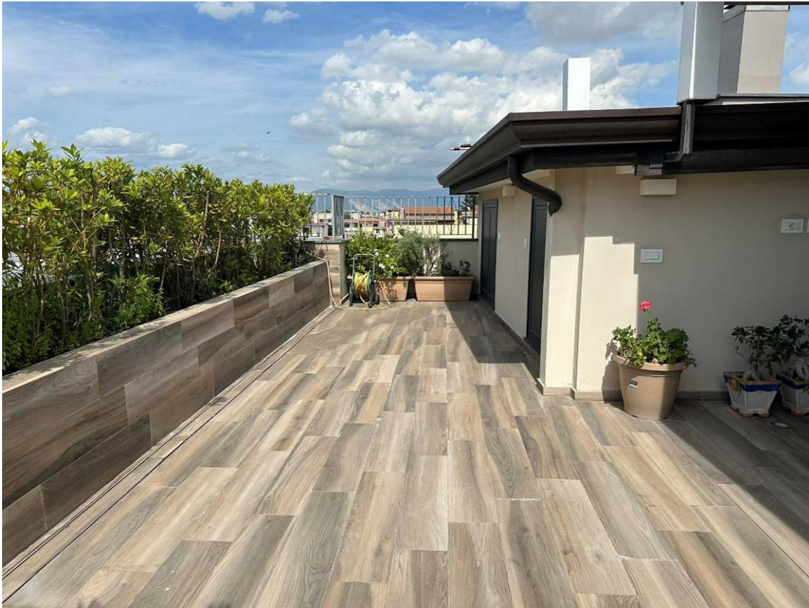
Foto 43 - Il sub 8 – terrazzo
