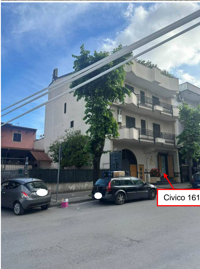
Foto 02 – Il fabbricato dalla via A. De Gasperi
