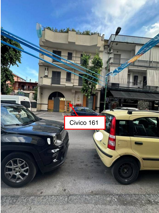
Foto 01 – Il fabbricato dalla via A. De Gasperi
