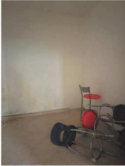
Foto 3 - Vano piano terra
