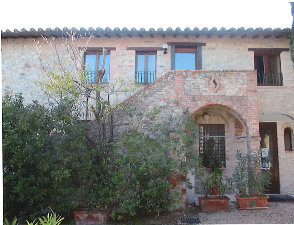
Foto n.24: particolare del prospetto ovest con il portoncino di accesso al piano terra e la scala esterna che conduce al portoncino di accesso del piano primo.
