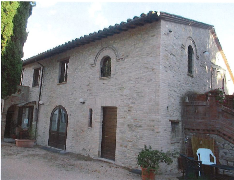
Foto n.25: veduta di parte dei prospetti sud e ovest del fabbricato ex colonico.
