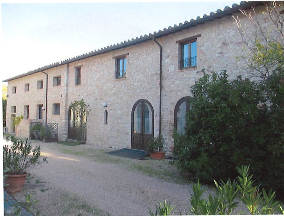
Foto n.23: prospetto ovest del fabbricato ex colonico con parte della corte pertinenziale.
