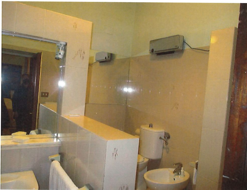
Foto n.62: particolare del bagno dell'ala ovest al piano primo della villa padronale.
