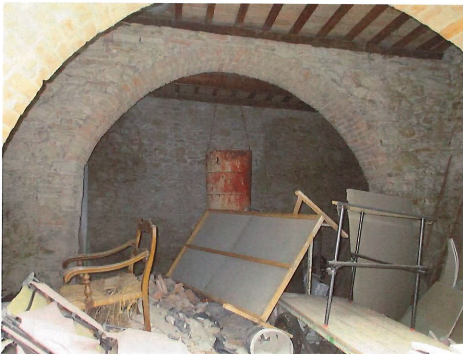
Foto n.30: altro particolare del piano interrato allo stato grezzo.
