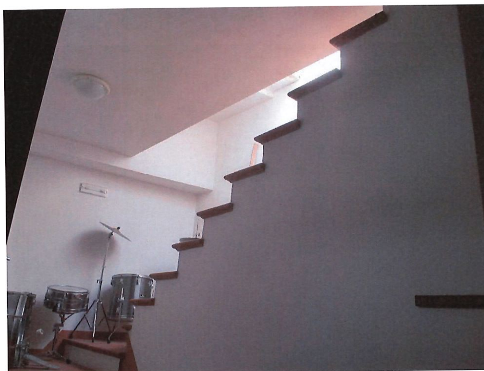
Foto n.20: scala di collegamento tra il piano terra e il piano primo (copertura) del centro congressi.
