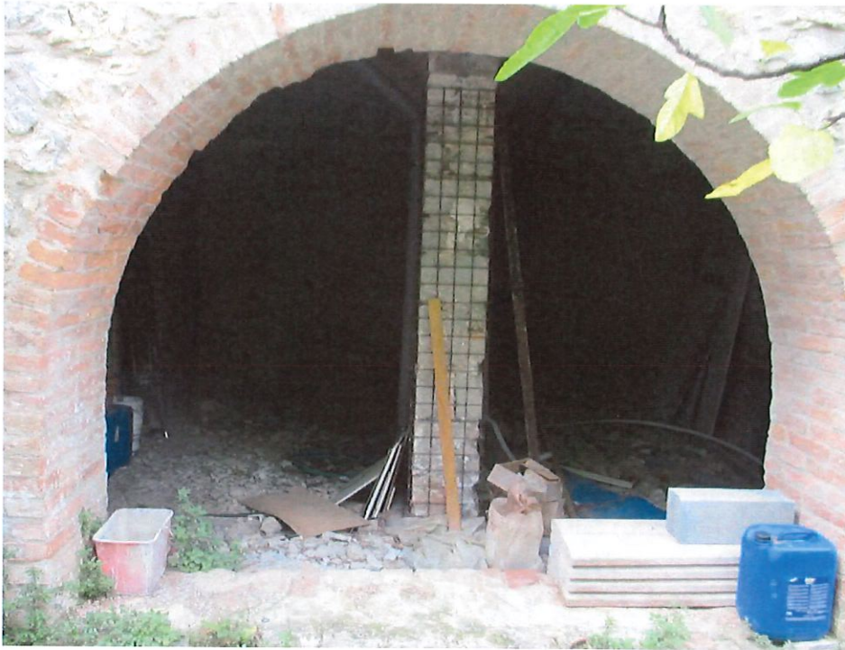
Foto n.29: altro particolare del piano interrato allo stato grezzo.
