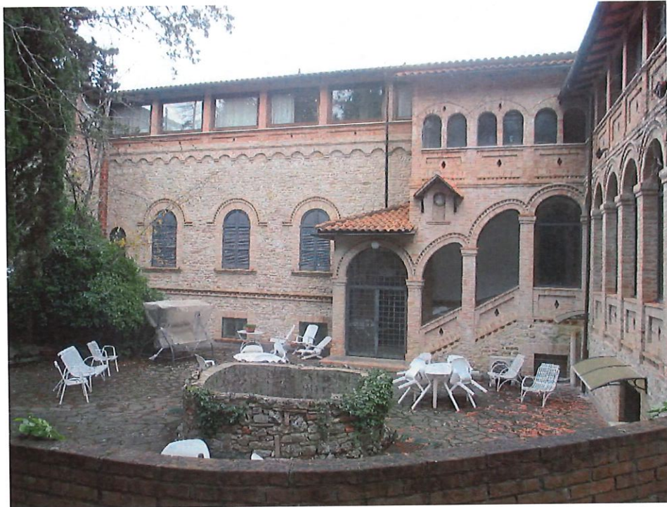
Foto n.43: prospetto sud della villa padronale con il particolare delle logge e della corte pertinenziale.
