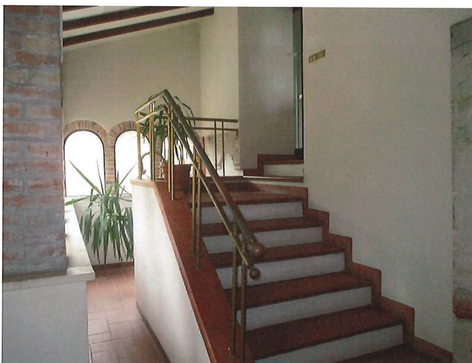
Foto n.70: rampa di scale che conduce alle aule del piano secondo rialzato.
