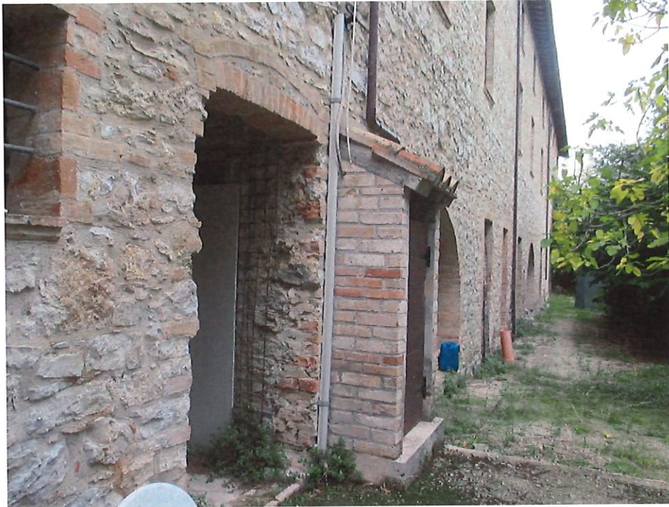
Foto n.27: particolare del prospetto est del piano interrato.
