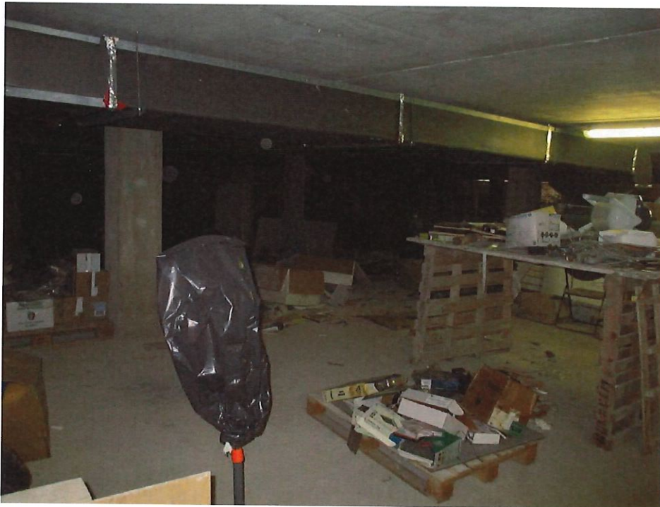
Foto n.18: altro particolare del piano interrato.
