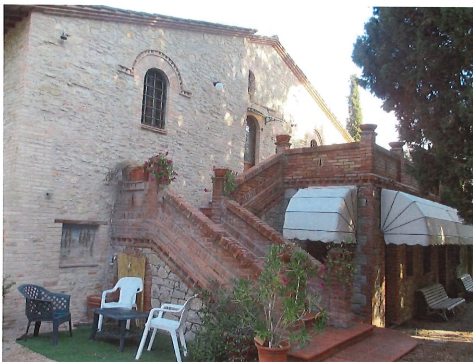
Foto n.26: prospetto sud con il particolare della scala esterna di collegamento al piano primo che conduce ad un terrazzo sovrastante il portico chiuso al piano terra adibito a sala colazione.
