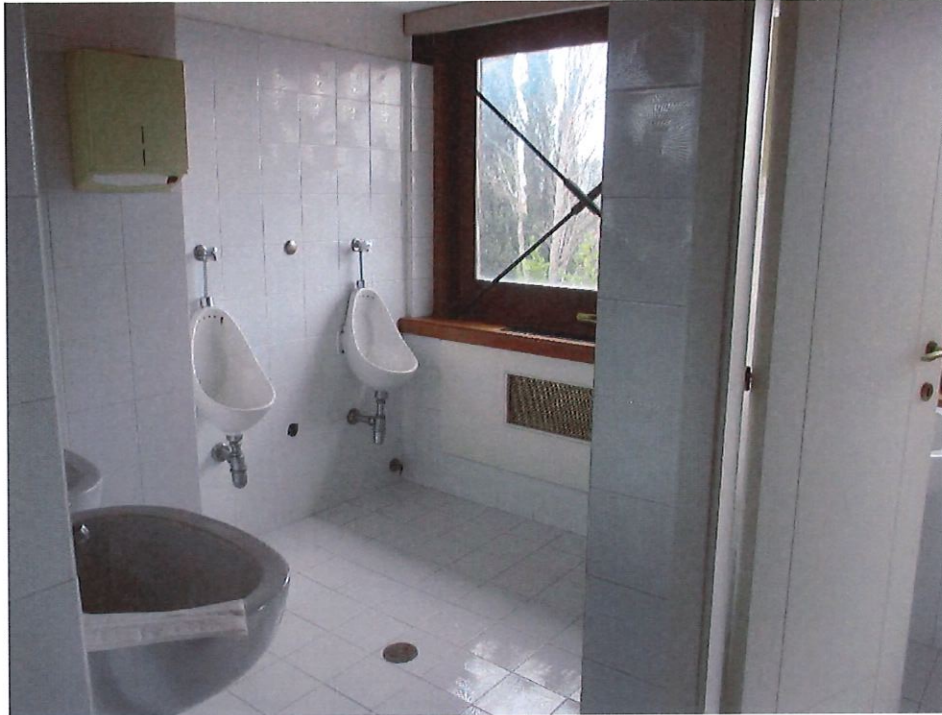
Foto n.75: particolare dei bagni al piano secondo della villa padronale.
