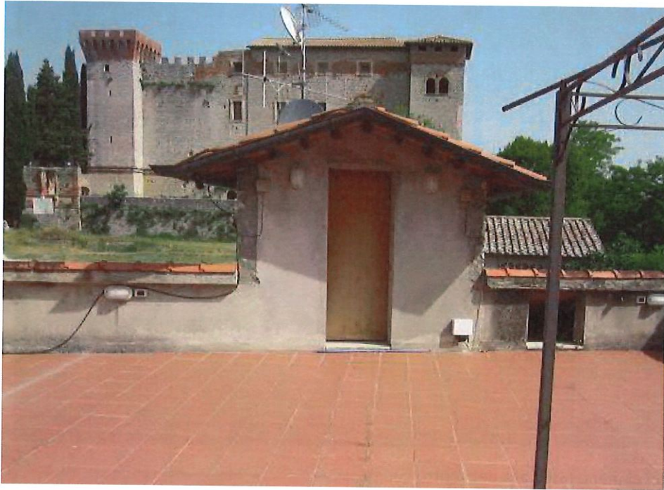
Foto n.21: particolare del lastrico solare del centro congressi. Sullo sfondo il castello di Pieve del Vescovo.
