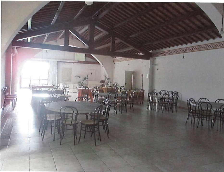
Foto n.13: altro particolare della sala della foto precedente.
