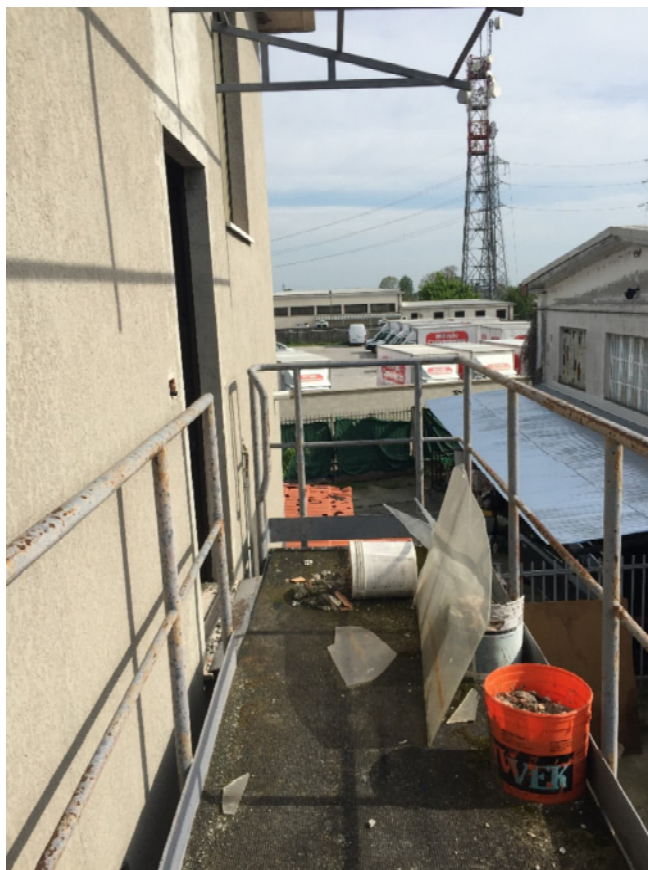
Foto 23 - Accesso dalla scala esterna
