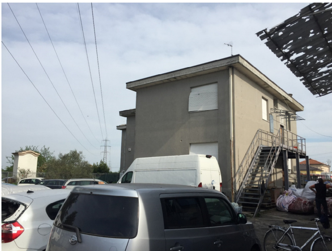
Foto 20 - Il fabbricato ad uso ufficio
