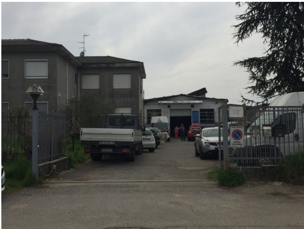
Foto 01 - Accesso al fabbricato al civico 112 di via Parini
