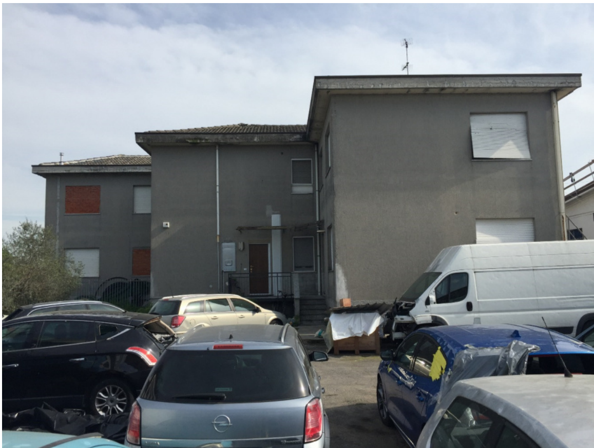
Foto 19 - Il fabbricato ad uso ufficio
