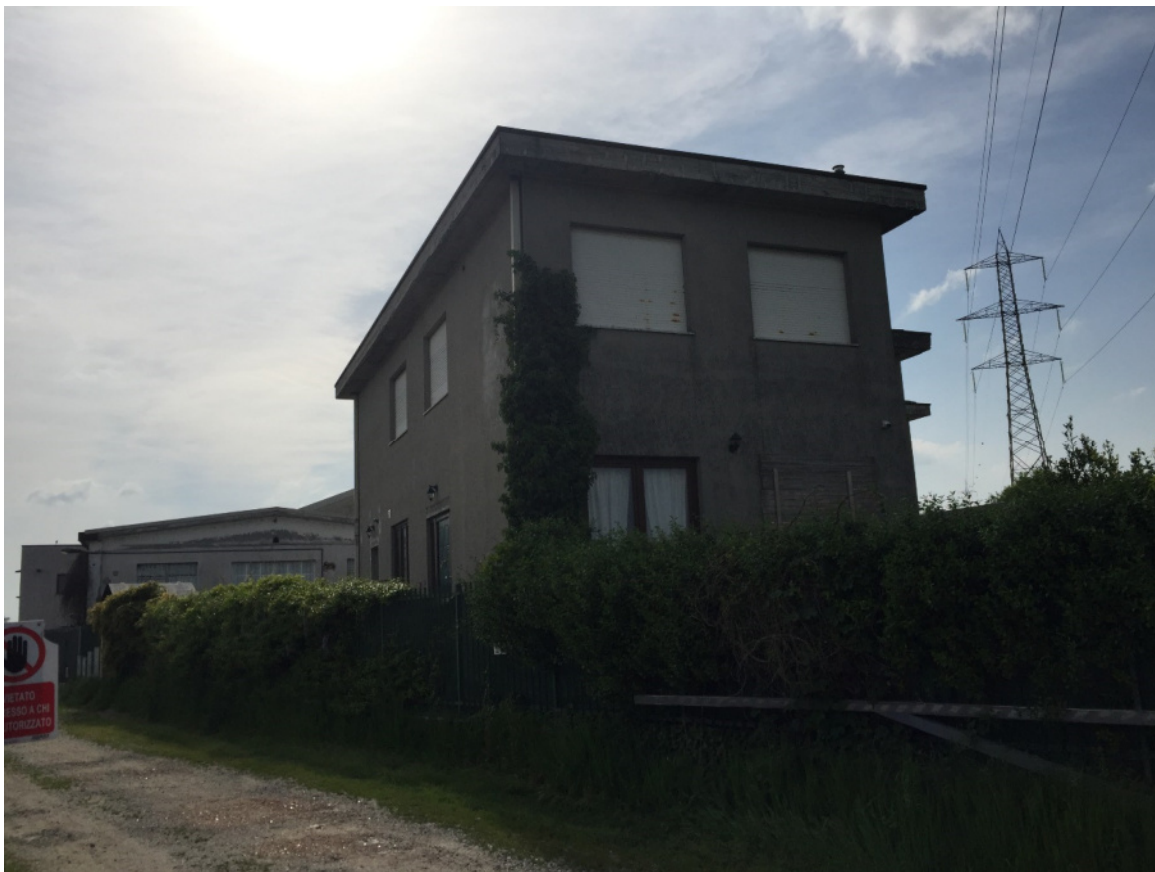
Foto 21 - Il fabbricato ad uso ufficio
