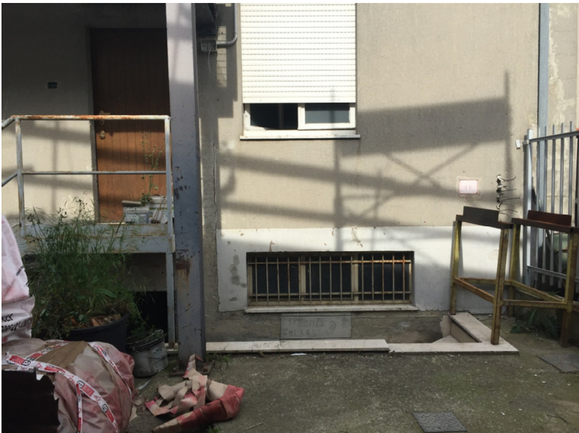
Foto 36 - Ingresso alla cantina al piano terra
