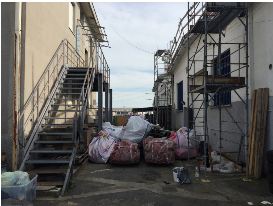
Foto 22 - Accesso all'unità ad uso ufficio dalla scala esterna
