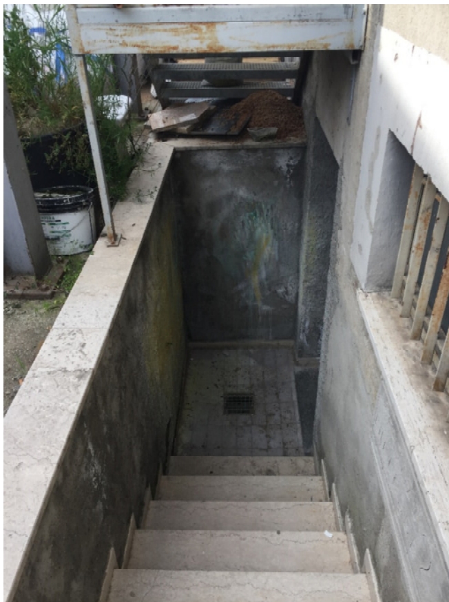
Foto 37 - Scala di accesso alla cantina al piano seminterrato
