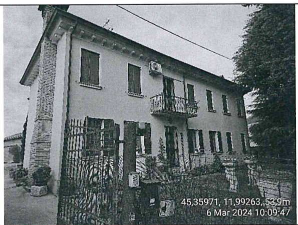
Porzione di abitazione vista da Via Caovilla
