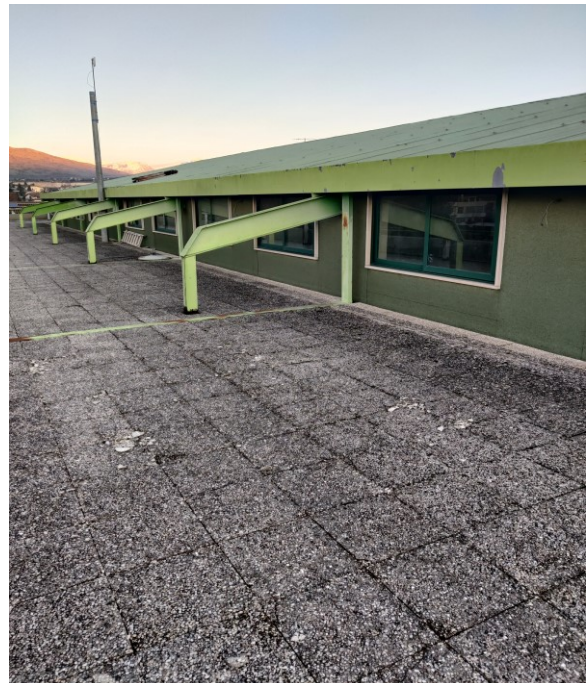
(Foto 16) - vista Copertura
