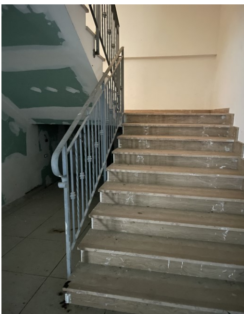
(Foto n.1 e 2) – piano seminterrato e scala interna
