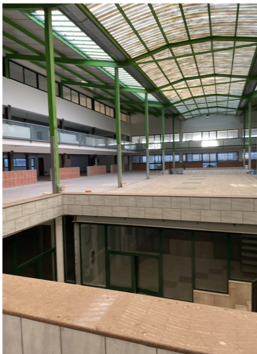
Foto 6 – Piazza centrale piano terra
