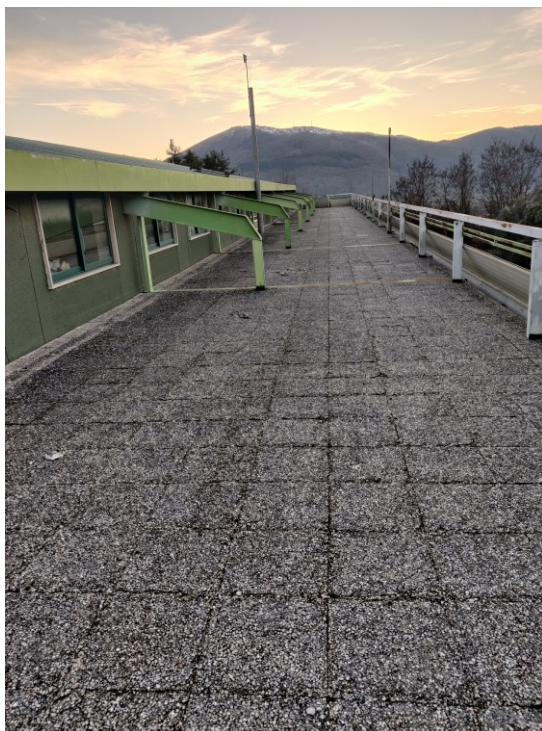
(Foto 17) - vista Copertura
