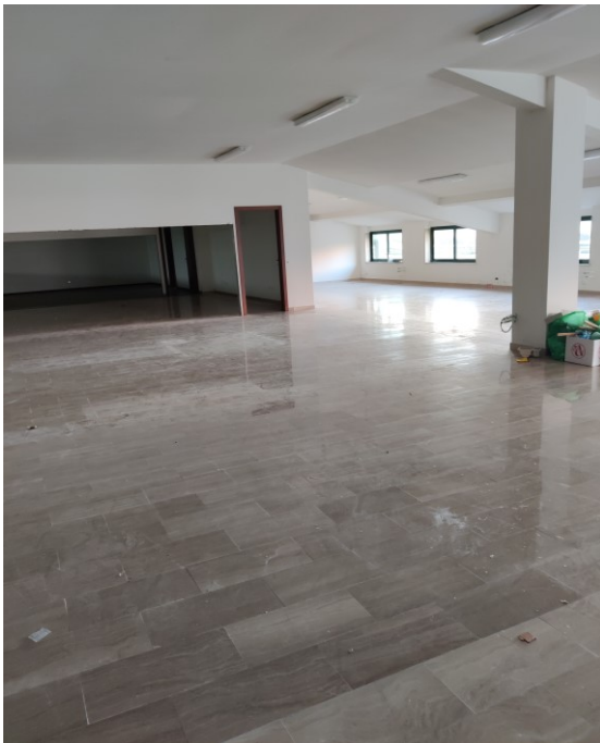
(Foto 15) piano secondo – locali tecnici
