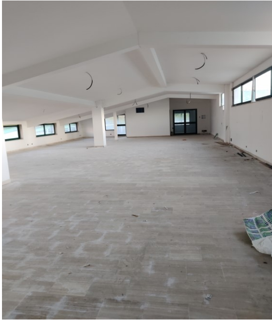
(Foto 14) piano secondo – locali tecnici
