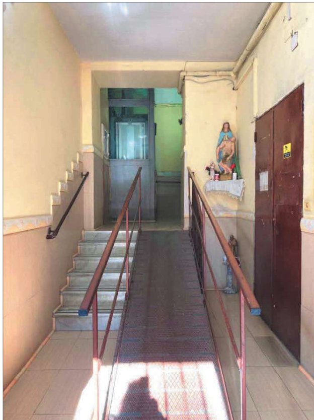
Foto n. 4: Fabbricato interessato – androne di accesso
