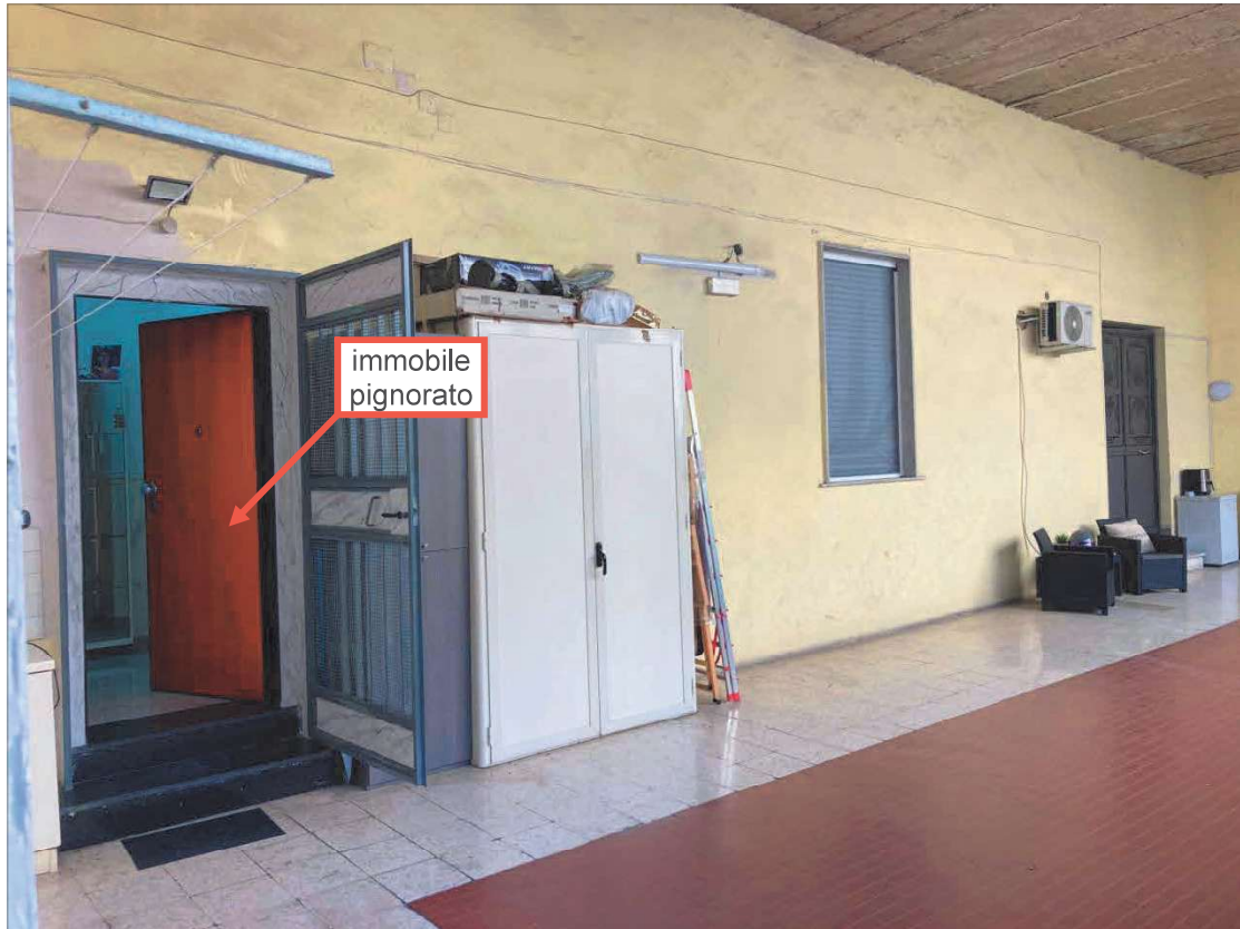
Foto n. 5: Immobile pignorato – ballatoio comune di accesso
