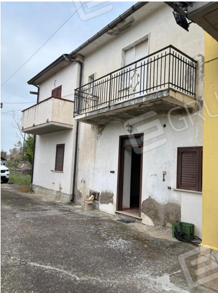
Foto n. 1: Prospetto principale del Fabbricato adibito a civile abitazione
