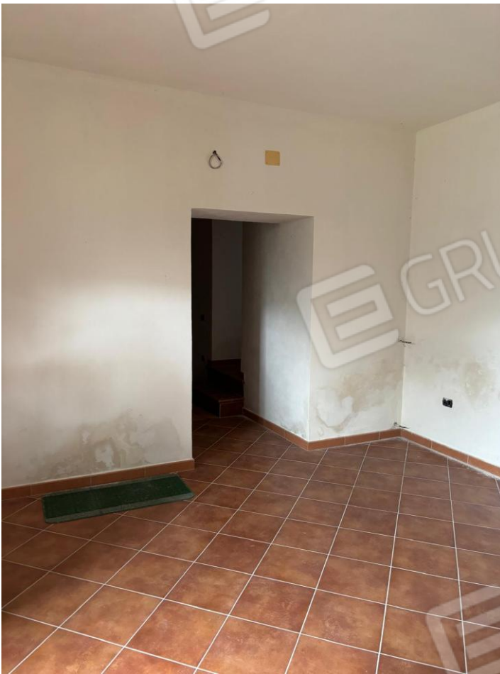
Foto n. 3: Fabbricato adibito a civile abitazione – Cantina 1
