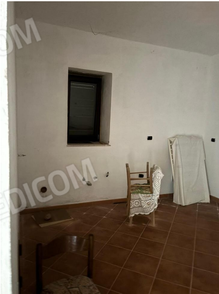
Foto n. 4: Fabbricato adibito a civile abitazione – Cantina 2
