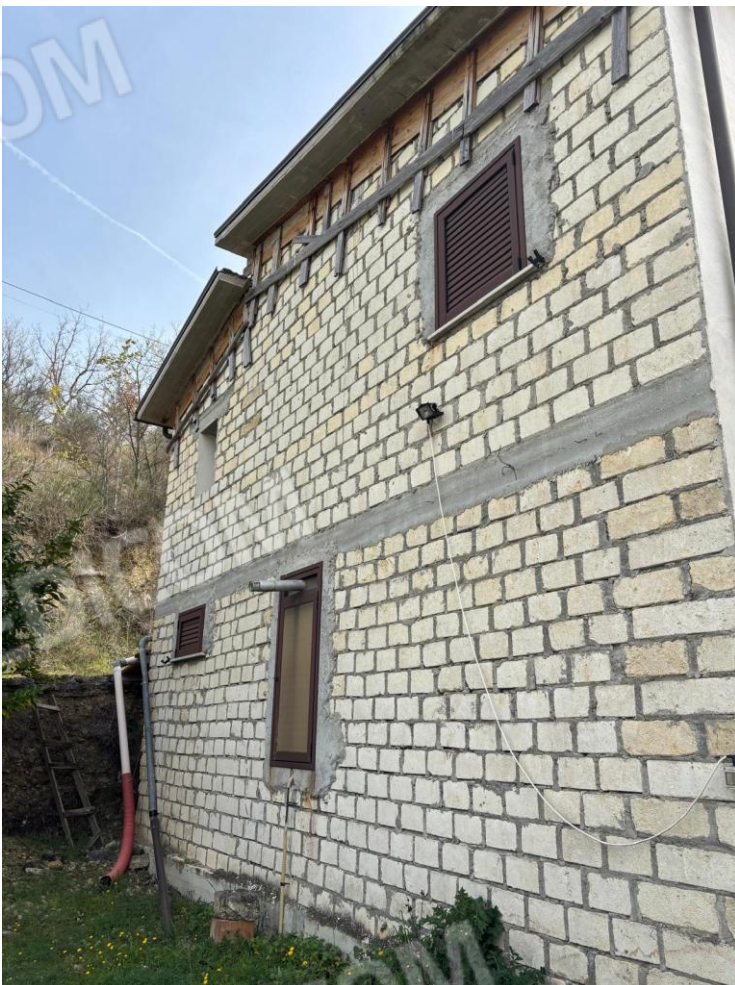
Foto n. 2: Prospetto laterale del Fabbricato adibito a civile abitazione
