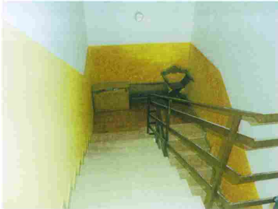
Foto n° 21 – Vista dal pianerottolo di accesso all'abitazione-A1 della scala di accesso alla stessa.
