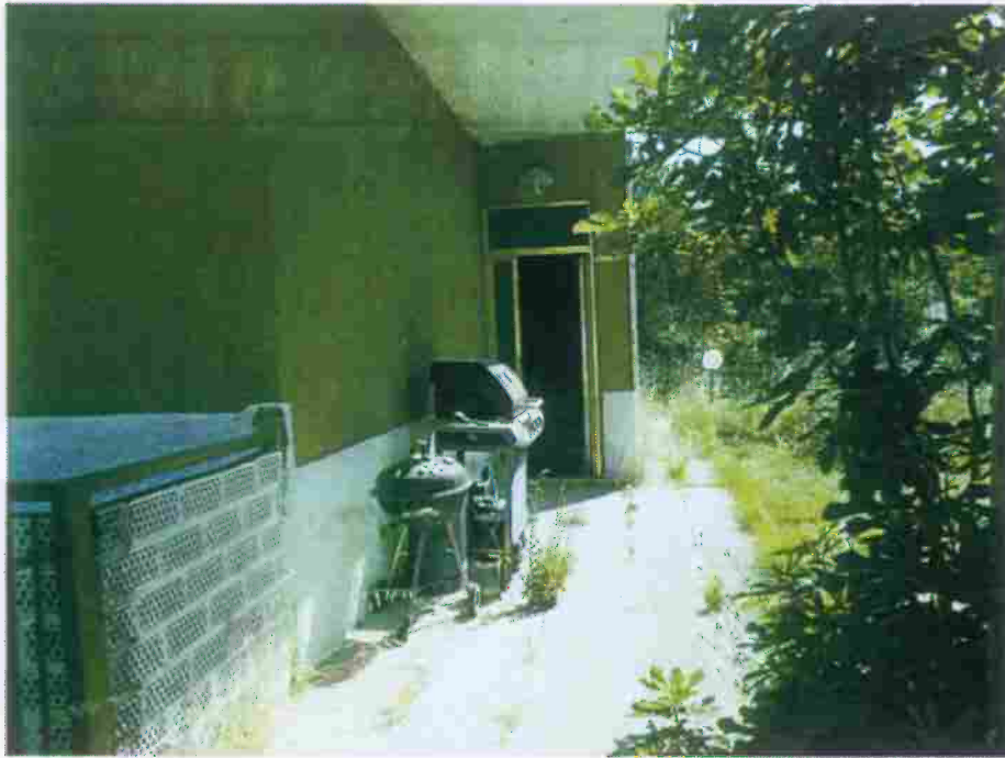
Foto n° 19 – Vista del portone esterno d'ingresso al fabbricato nel quale è ubicato il bene A1.
