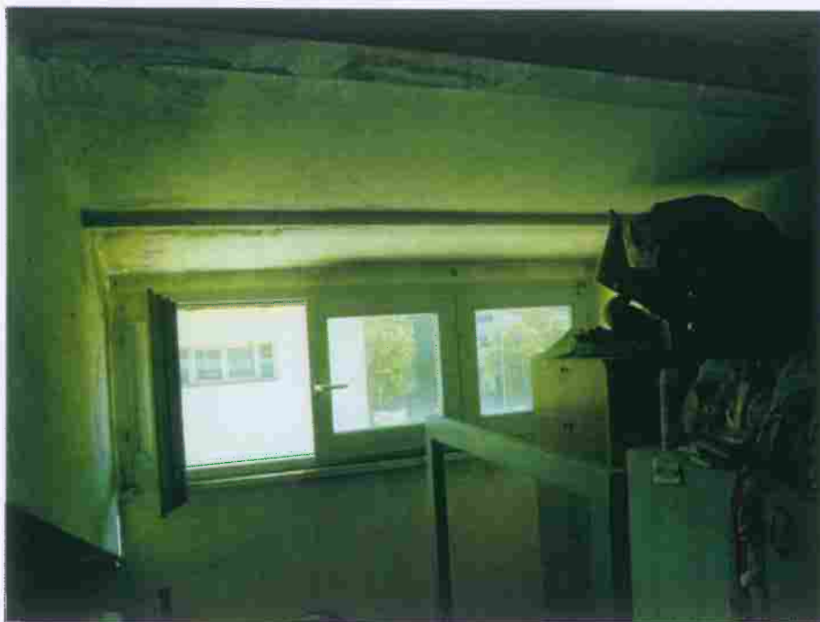
Foto n° 49 – Locale Camera n. 2.
