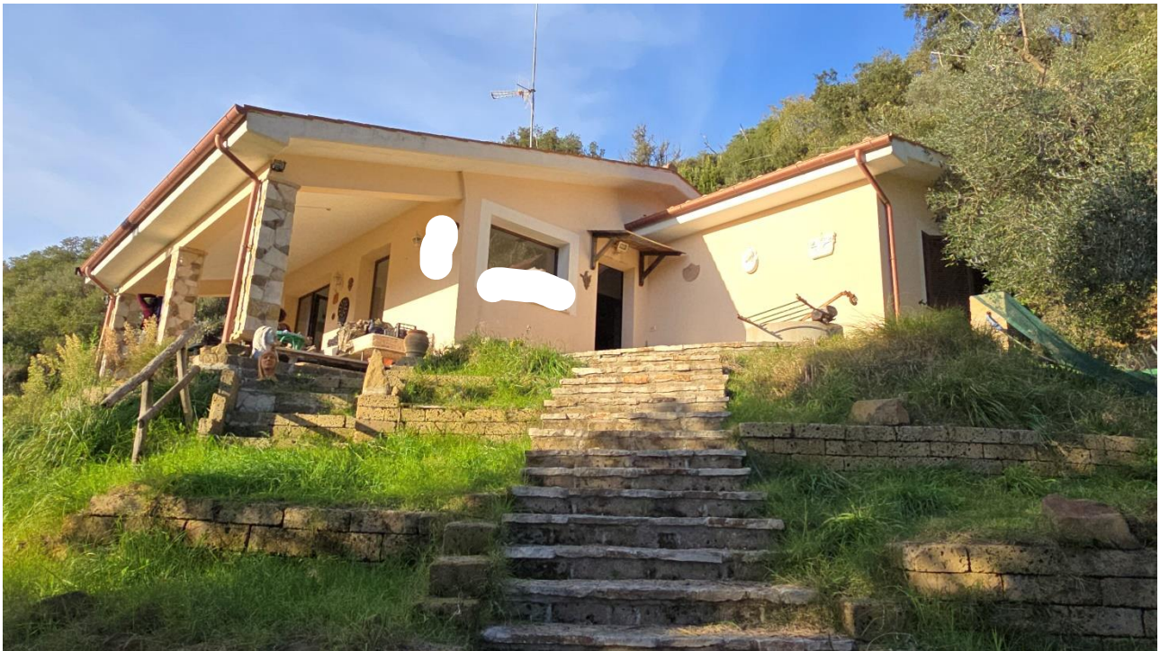
Fig. 8 - Vista prospetto est (ingresso)
