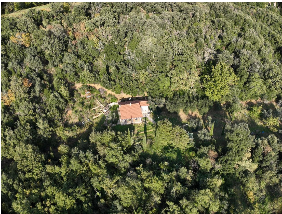
Fig. 1 e 2 – Vista aerea del fabbricato e del terreno circostante
