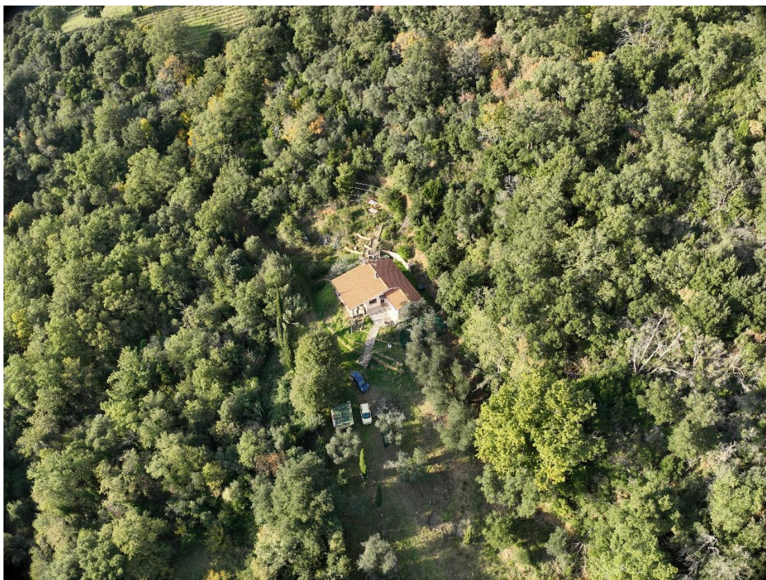
Fig. 3 e 4 - Vista aerea del fabbricato e del terreno circostante
