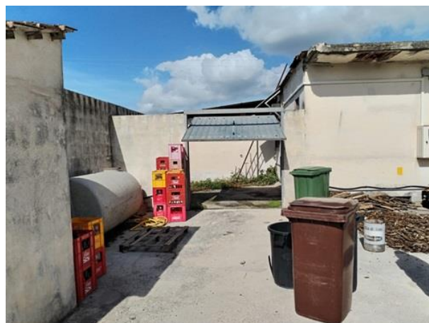
Foto n°12- Vista area pertinenziale retrostante – lato nord-ovest
