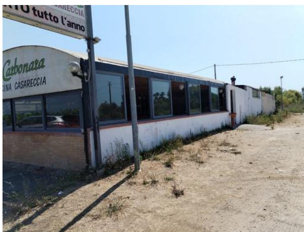
Foto n°2- Vista prospetto laterale ovest
