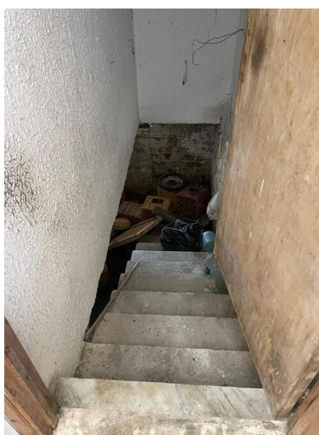
Foto n°9- Vista scala di accesso al piano interrato
