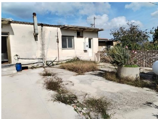
Foto n°11- Vista area pertinenziale retrostante – lato nord-est
