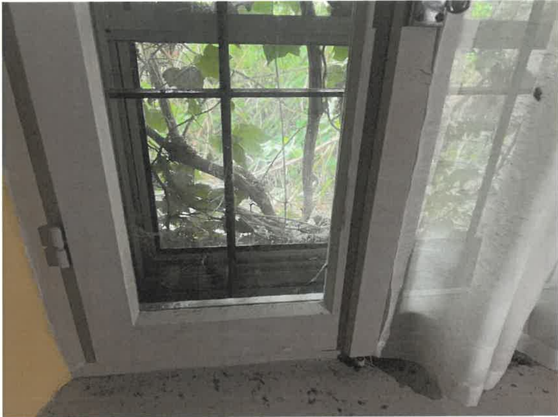
Figura 15 dettaglio infissi esterni
