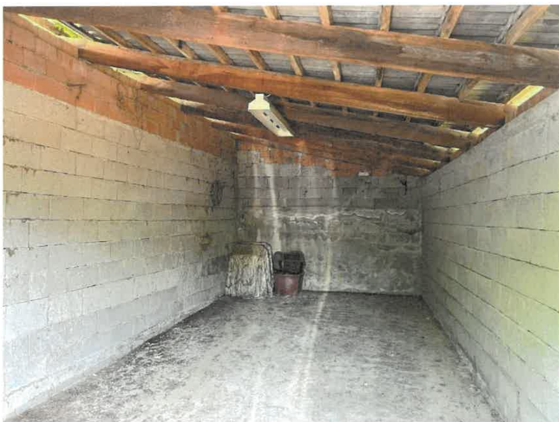
Figura 27 nm 45 sub 4 autorimessa
