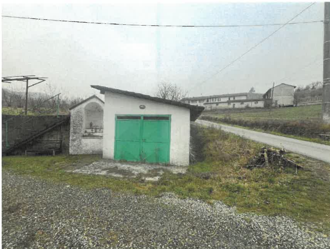
Figura 26 nm 45 sub 4 autorimessa
