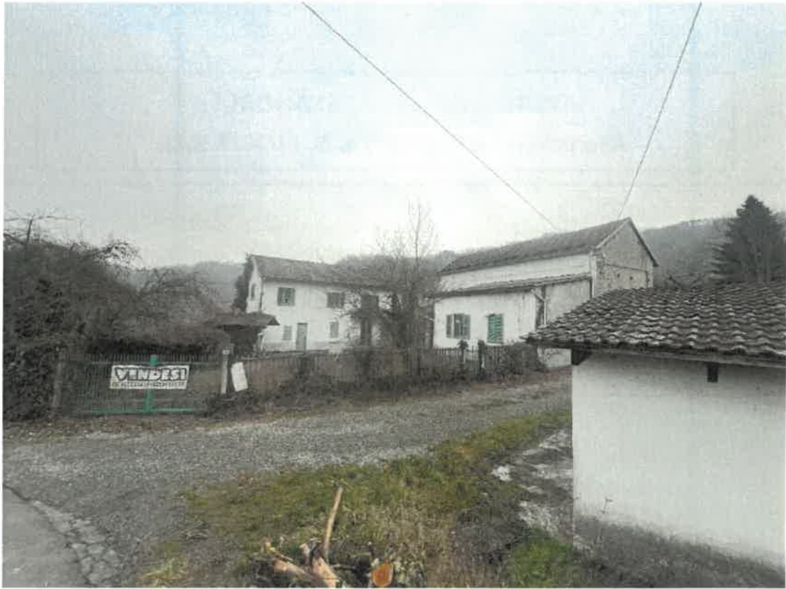
Figura 1 fabbricato nm 45 sub 3 veduta generale
