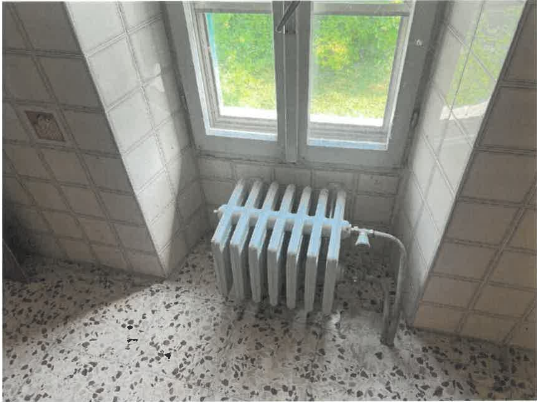
Figura 19 dettaglio infissi e elementi radianti p1
