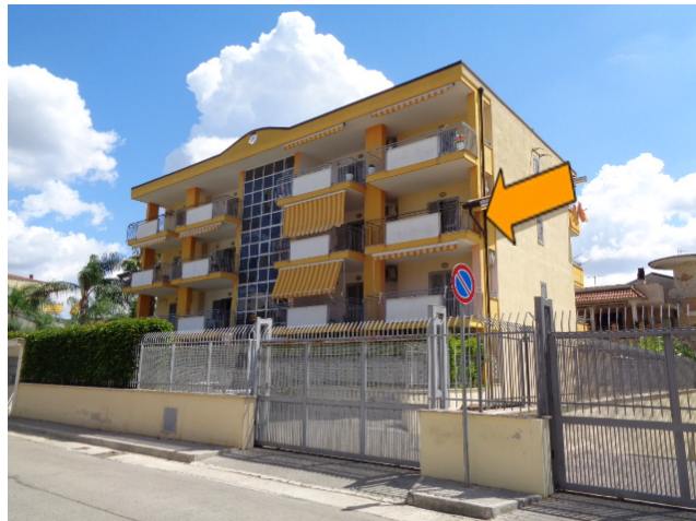
Prospetto del fabbricato da Via Salerno
