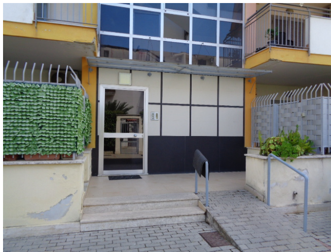
Portone d'ingresso al fabbricato
