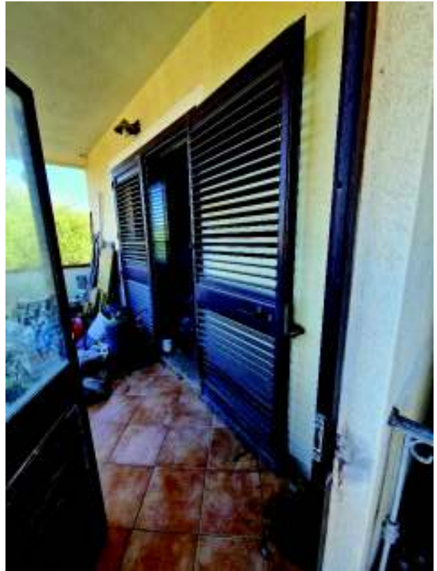
Veranda e ingresso unità immobiliare
