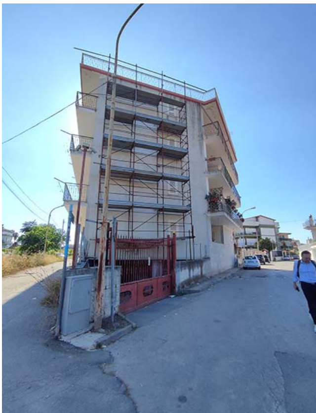
Foto 01. Edificio dall'inters. tra via A. Da Messina e via Cassario
