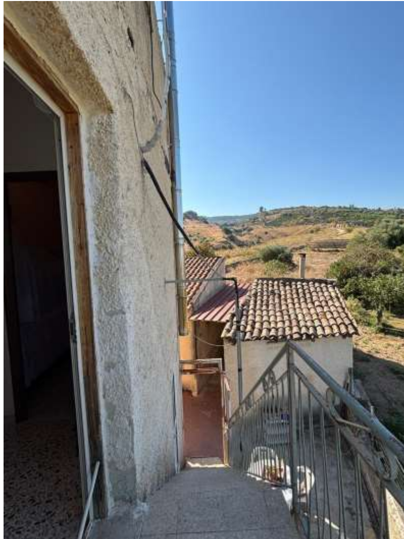
Manufatto di pertinenza dell'edificio, posto nella parte sud ovest del terreno
