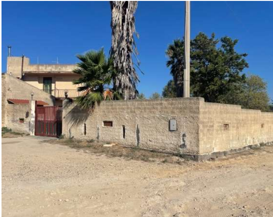
Il cancello d'ingresso posto nel lotto indicato nel N.C.T. di Carlentini foglio n. 30 particella n. 12
