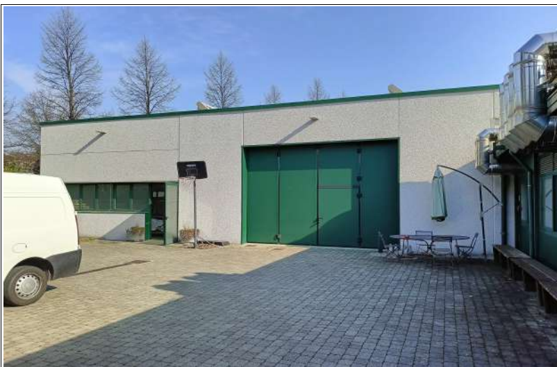
Il portellone di ingresso del capannone/laboratorio
