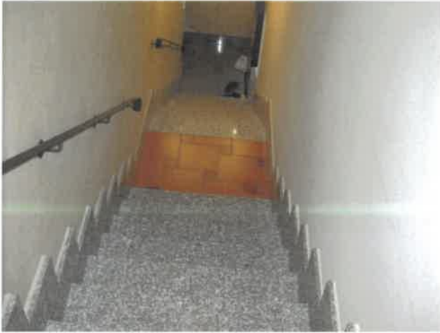
Scala ingresso alloggio piano primo 856 sub.3 - Lotto 1
