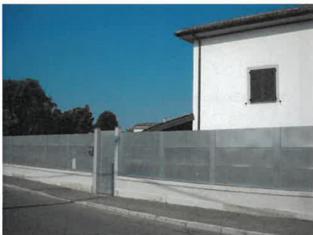
Recinzione ed ingresso pedonale Lotto 1
