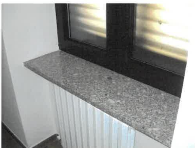
Serramenti alloggio piano primo (sub 4) Lotto 1
