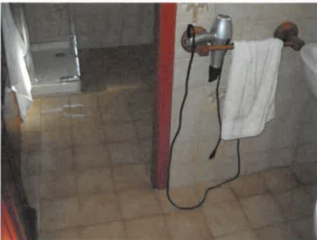
Bagno alloggio piano primo Lotto 1
