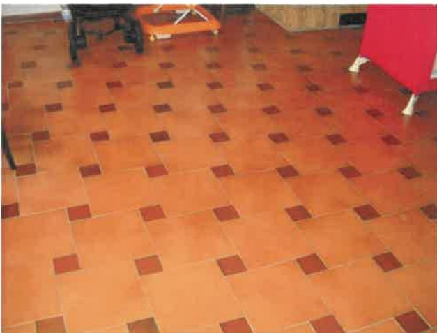
Pavimentazione alloggio piano primo Lotto 1
