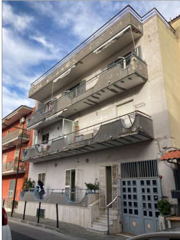
Foto n. 1: Fabbricato sito in Via Ada Negri n.3, Mugnano di Napoli (Na)
