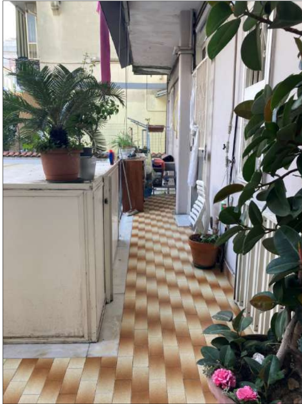
Foto n. 25: Immobile pignorato – balcone prospiciente il cortile posteriore e accesso al cortile
