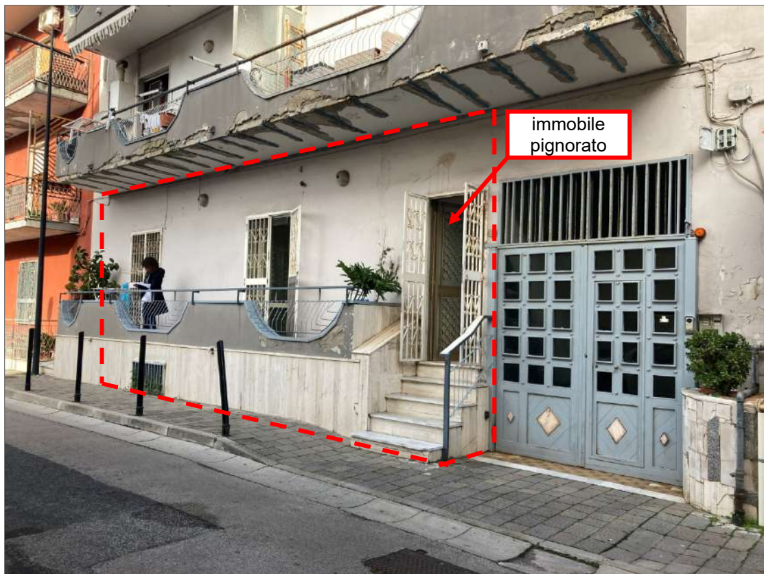
Foto n. 2: Fabbricato sito in Via Ada Negri n.3, Mugnano di Napoli (Na) portone di ingresso ed immobile pignorato
