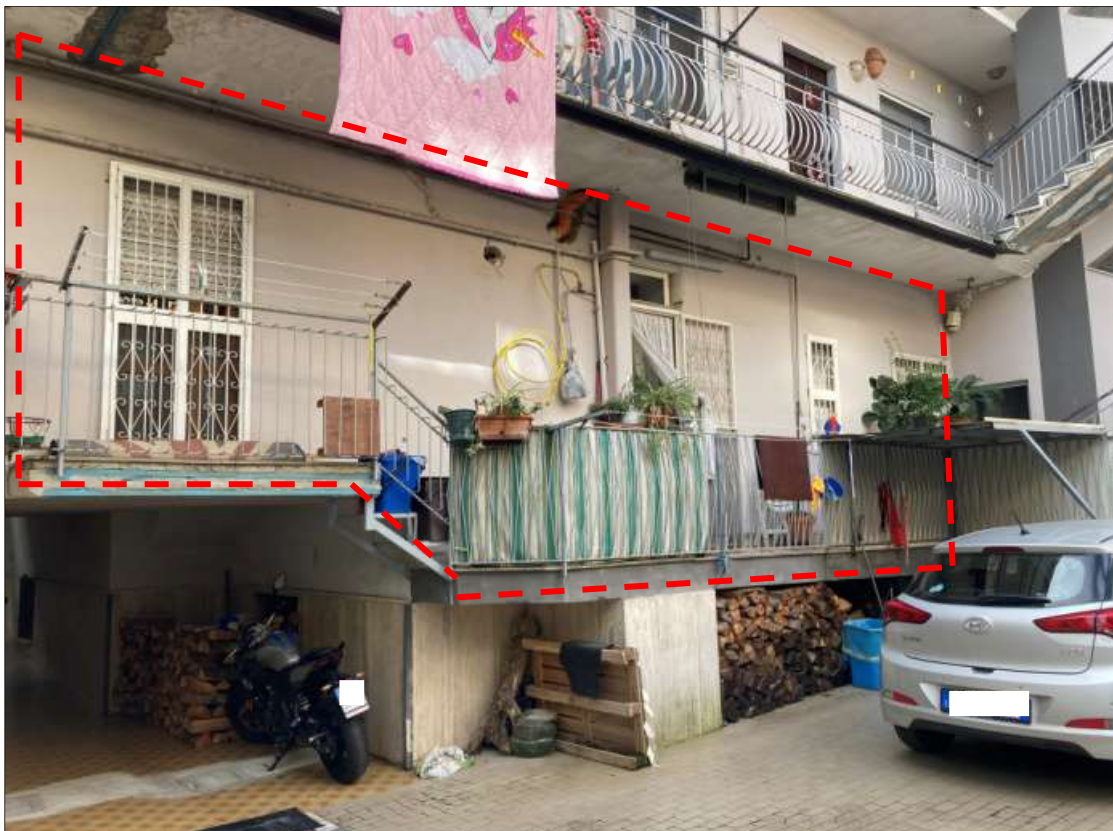
Foto n. 4: Fabbricato sito in Via Ada Negri n.3, Mugnano di Napoli (Na) prospetto posteriore ed immobile pignorato
