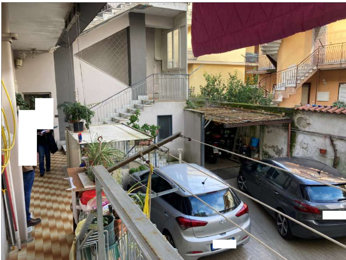
Foto n. 26: Immobile pignorato – balcone prospiciente il cortile posteriore e accesso al cortile
