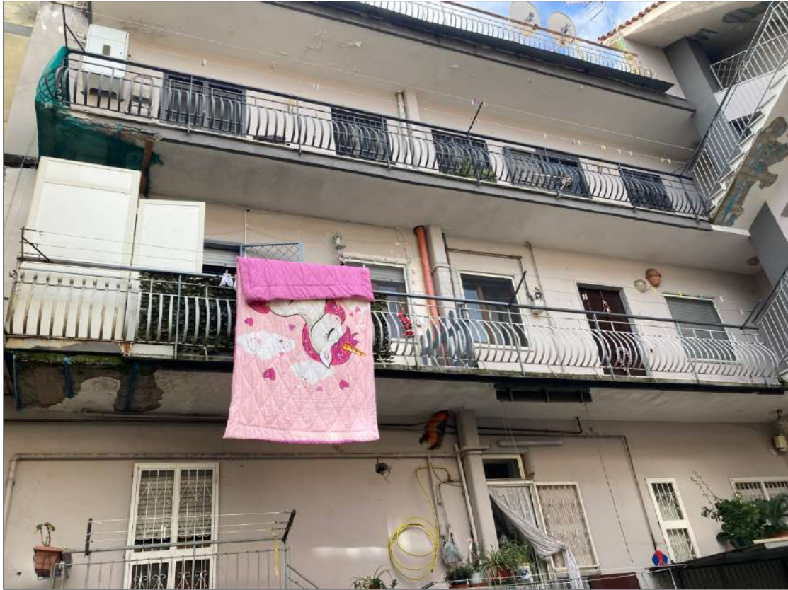
Foto n. 3: Fabbricato sito in Via Ada Negri n.3, Mugnano di Napoli (Na) – prospetto posteriore
