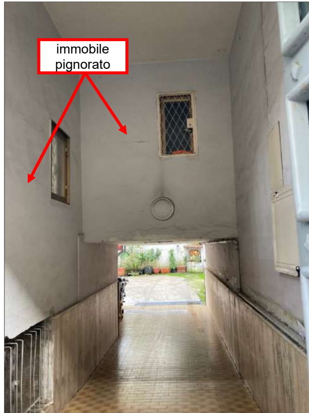
Foto n. 5: Fabbricato interessato – androne e bucatore immobile pignorato
