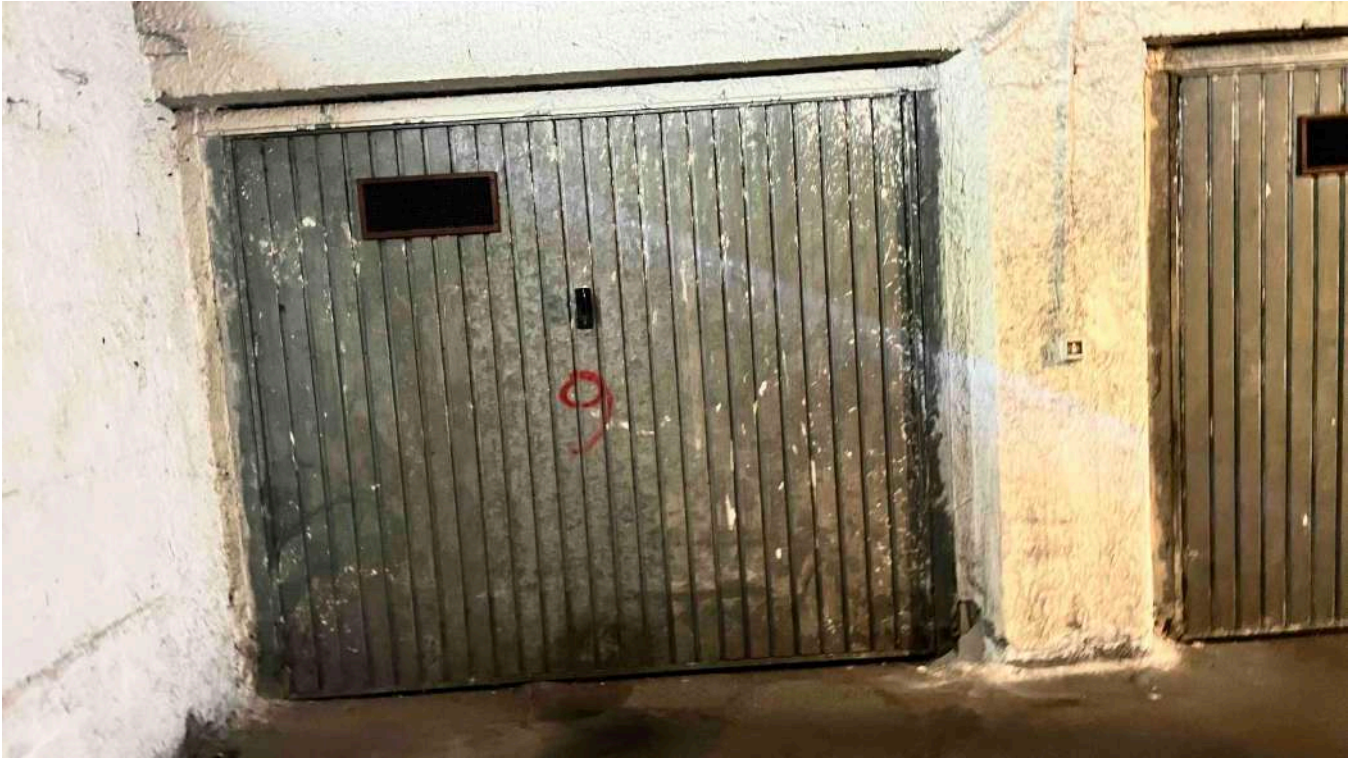
fig. 15 – Porta di ingresso garage
