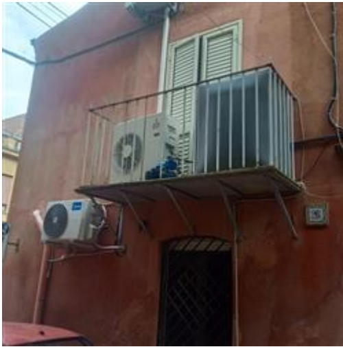
Foto n.1 Appartamento piano primo balcone via Vittorio Emanuele
