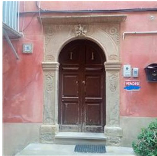
Foto n. 2 Portone ingresso da via Ciro Menotti 26
