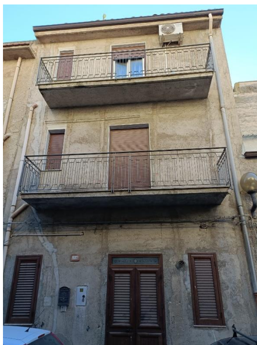
Foto 1. Vista esterna del fabbricato su via Antonio Gramsci n. 154
