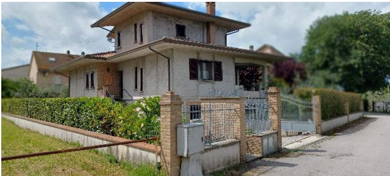
Foto n. 1. Vista panoramica dal via Ponte delle Cartiere
