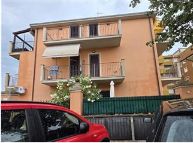
vista frontale edificio
