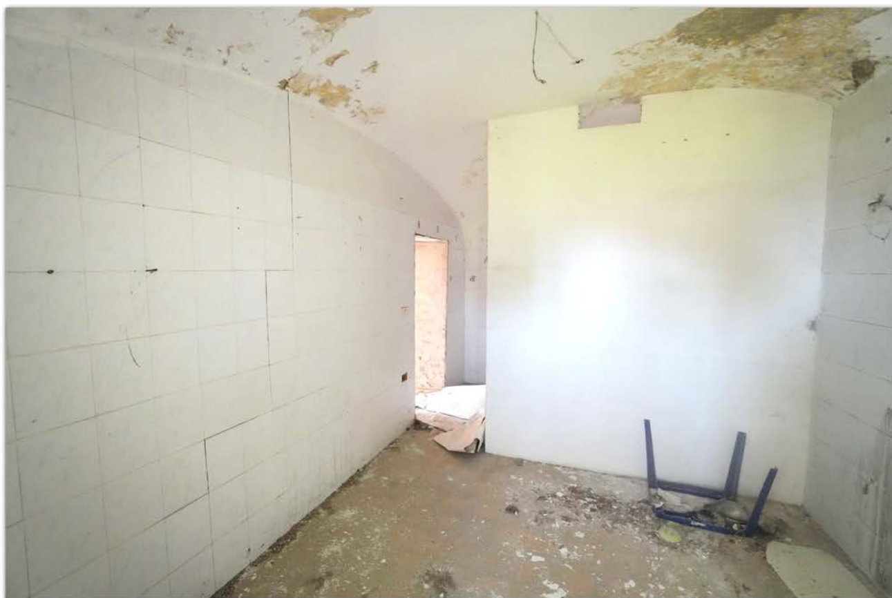
FOTO 9. Porzione di fabbricato colonico disposta su due livelli - Vano non abitabile al piano terra.
