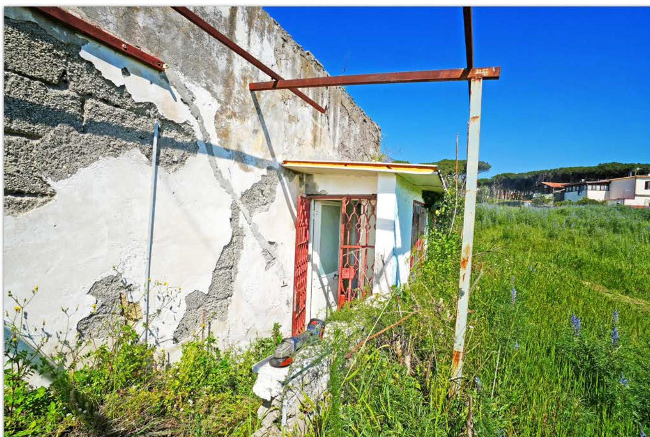
FOTO 8. Porzione di fabbricato colonico disposta su due livelli - Ingresso al piano terra.
