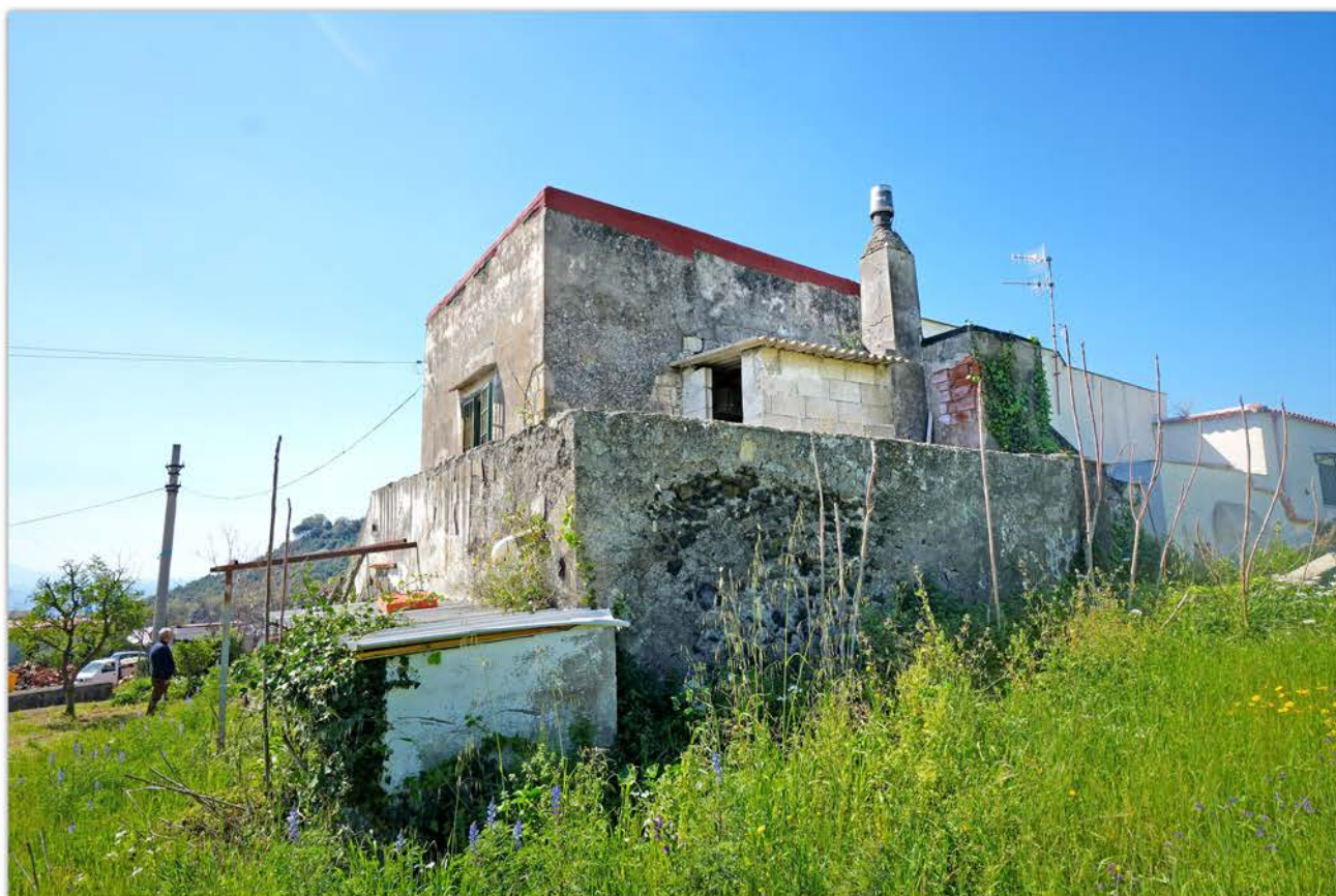
FOTO 7. Porzione di fabbricato colonico disposta su due livelli - Facciata postica del fabbricato.
