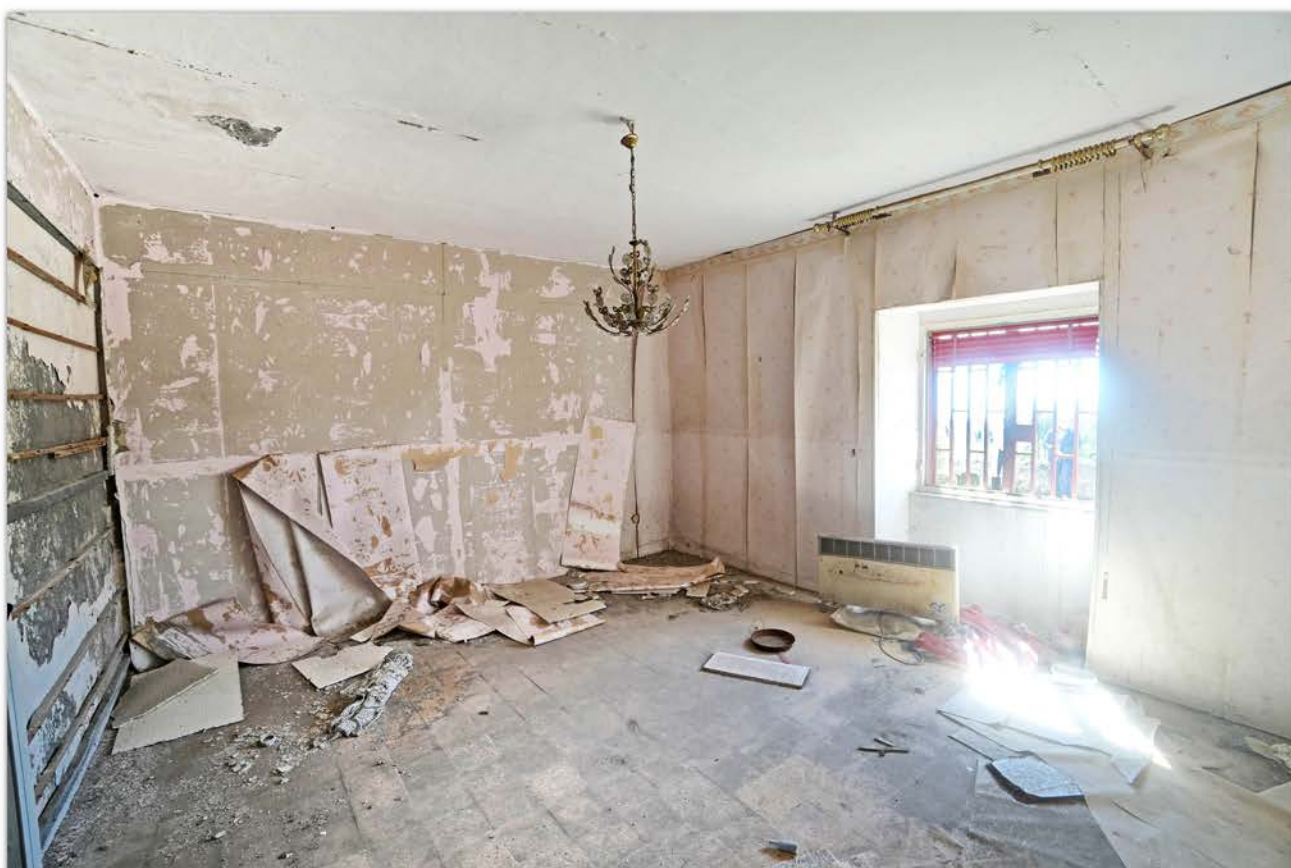
FOTO 10. Porzione di fabbricato colonico disposta su due livelli - Vano al piano terra.
