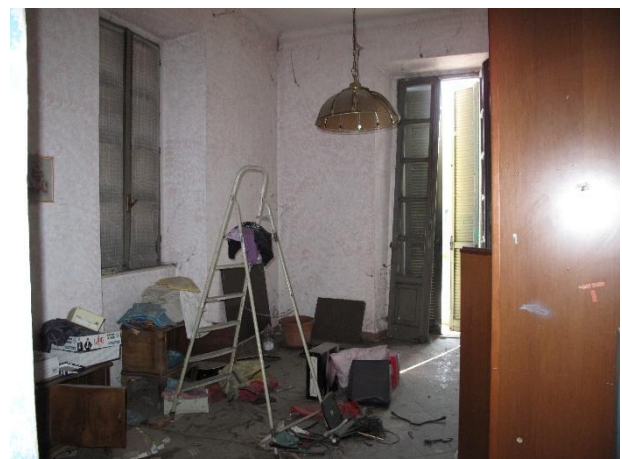
interno unità sub. 729 – locale in angolo verso strada
