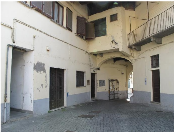
esterno fabbricato – corte interna e andito
