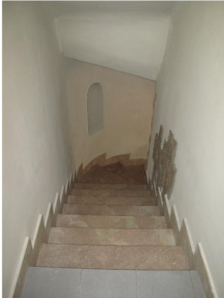
interno fabbricato – vano scala comune
