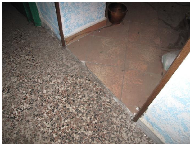
interno unità sub. 729 – pavimenti
