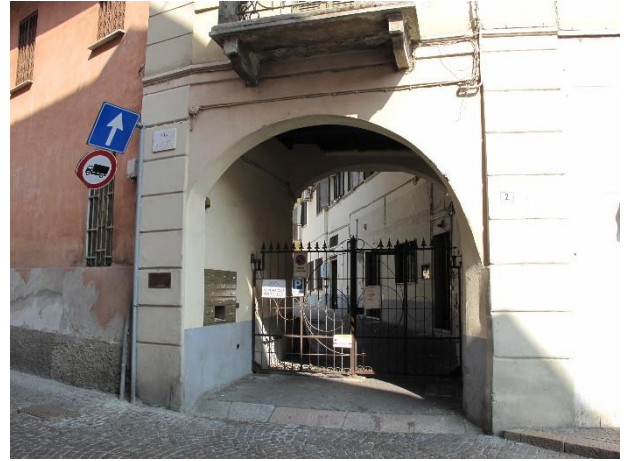
esterno fabbricato – andito d'ingresso comune
