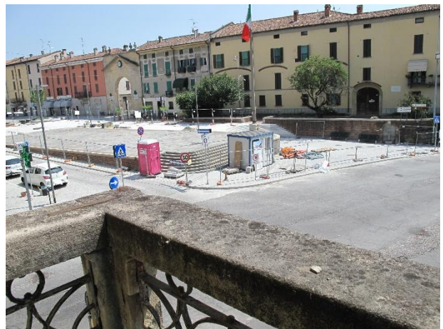
esterno unità sub. 729 – vista dal balcone
