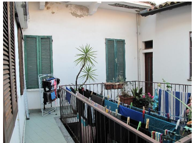
esterno fabbricato – ballatoio piano primo e finestre unità sub. 729
