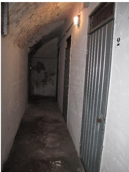
corridoio cantine comune
