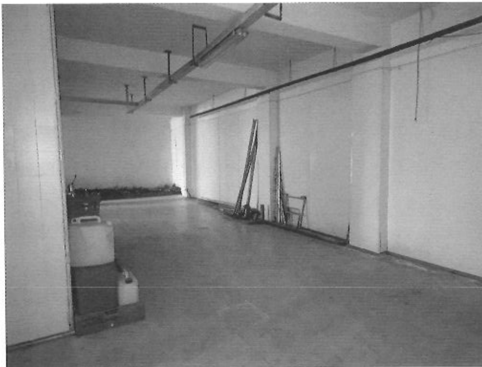
Foto N. 38 < Particolare: garage di proprietà – Alleg. N. 03
