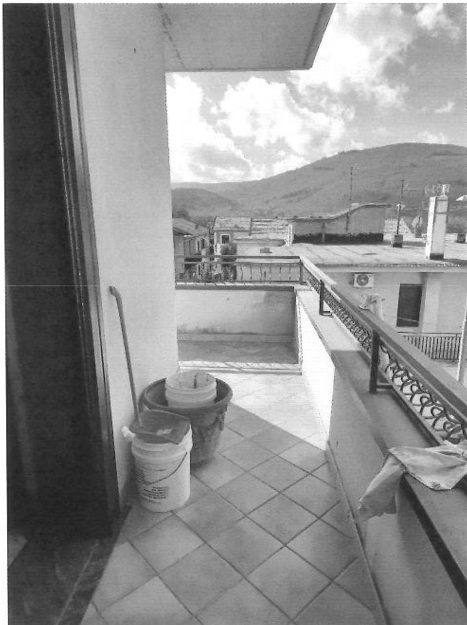
Foto N. 17 < Particolare: balcone che contorna l'unità abitativa – Alleg. N. 03 >
