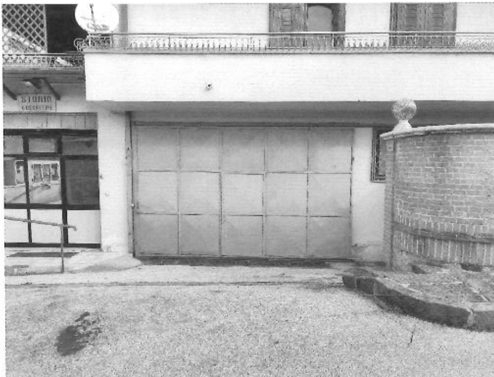
Foto N. 35 < Particolare: ingresso garage – Alleg. N. 03 >
