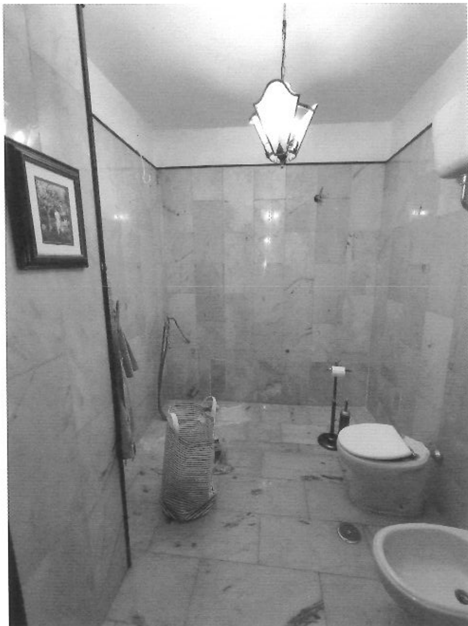
Foto N. 31 < Particolare: WC_2 interno camera da letto N_2 – Alleg. N. 03 >
