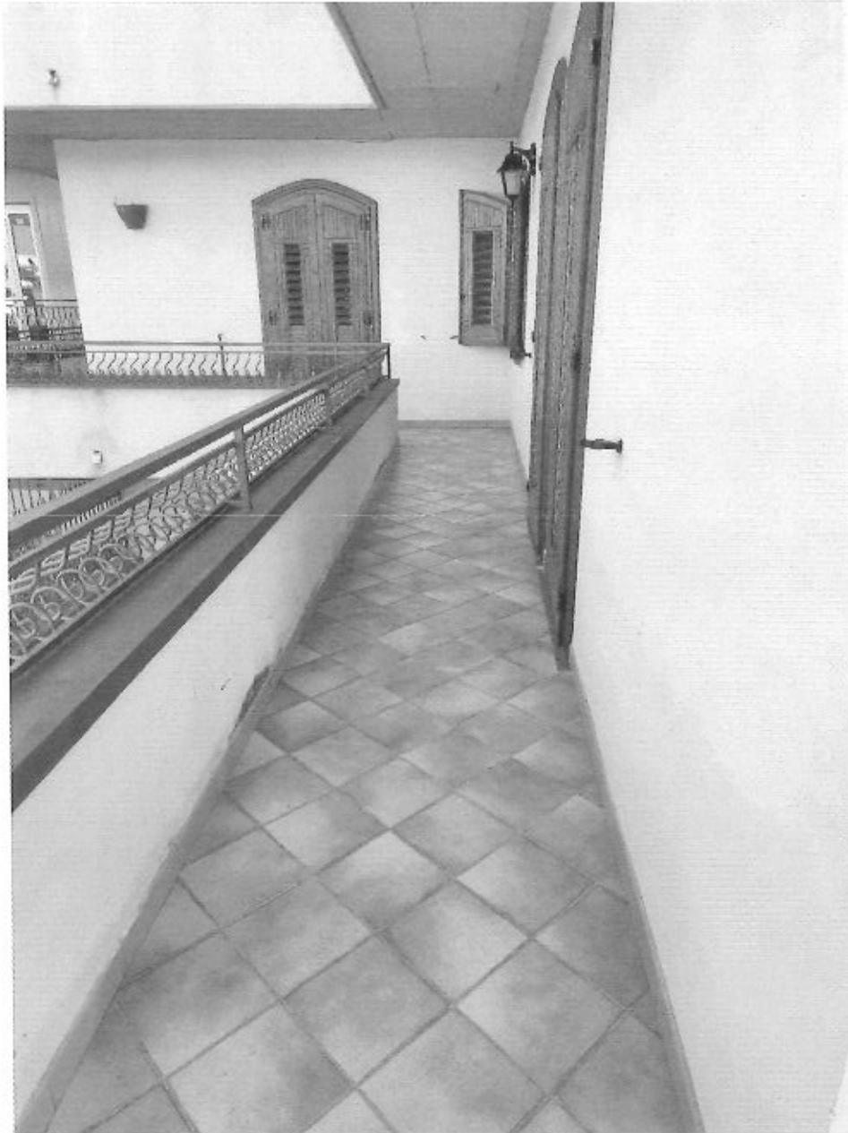
Foto N. 20 < Particolare: balcone che contorna l'unità abitativa – Alleg. N. 03 >
