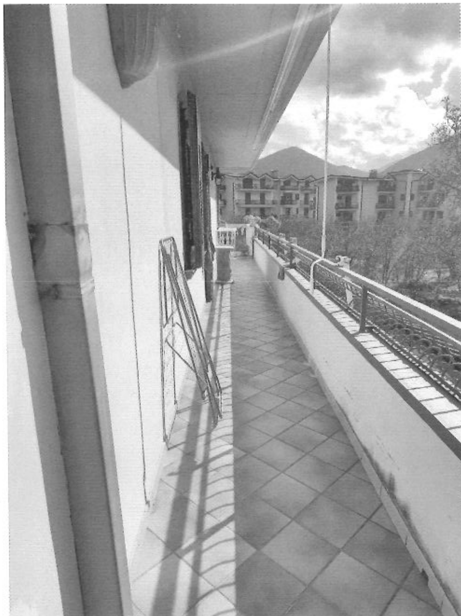
Foto N. 18 < Particolare: balcone che contorna l'unità abitativa – Alleg. N. 03 >
