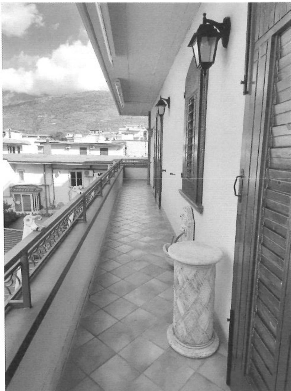
Foto N. 19 < Particolare: balcone che contorna l'unità abitativa – Alleg. N. 03 >
