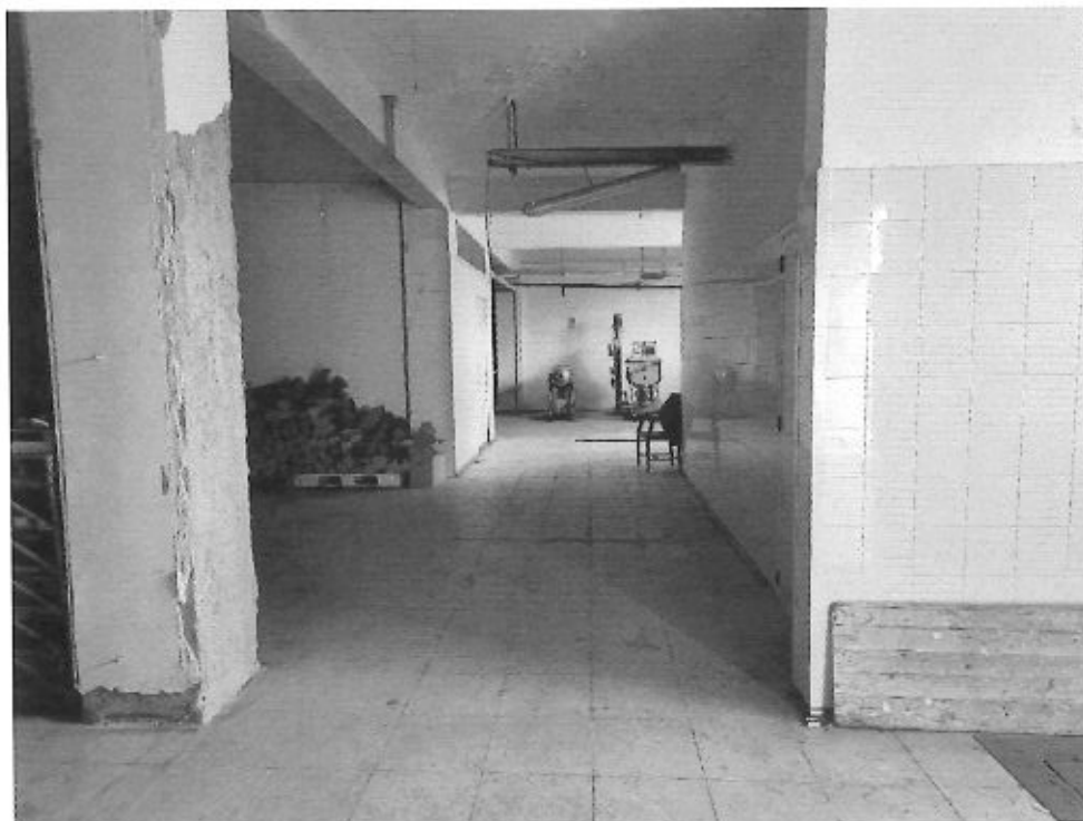
Foto N. 36 < Particolare: area di manovra - Ingresso garage – Alleg. N. 03 >
