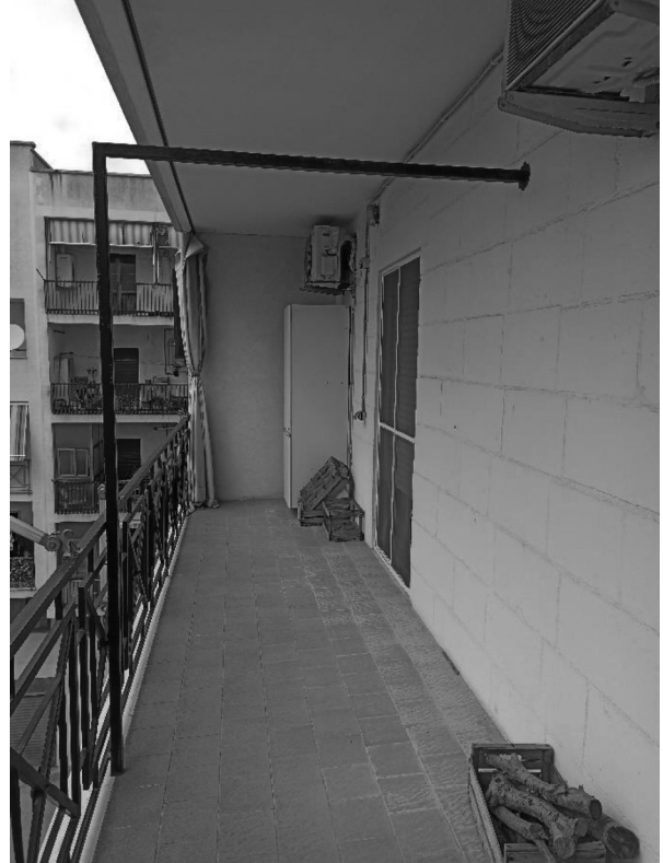
FOTO 17. Balcone a ovest
