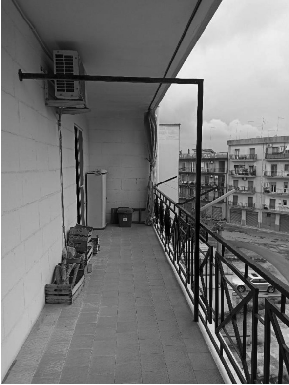
FOTO 16. Balcone a ovest
