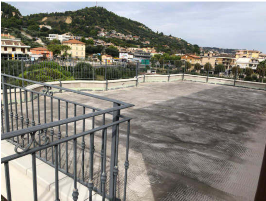
Foto 13: Vista esterna terrazzo al piano terzo
