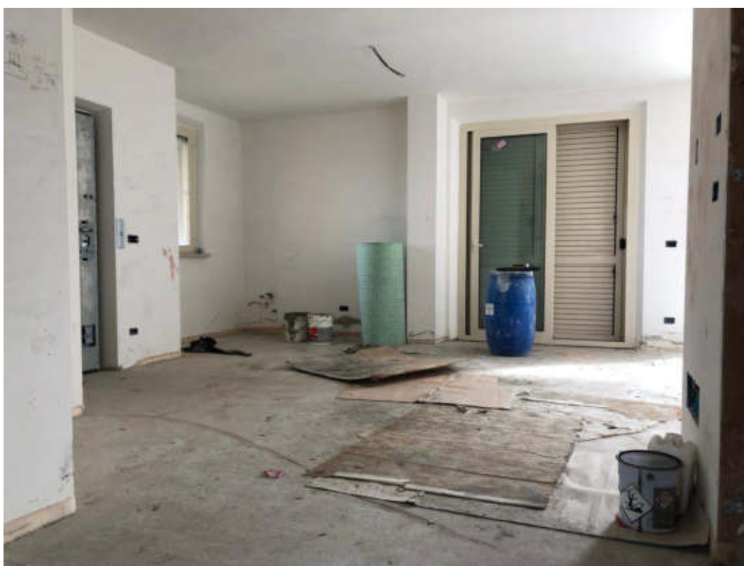
Foto 6: Vista locale pranzo-soggiorno al piano terzo
