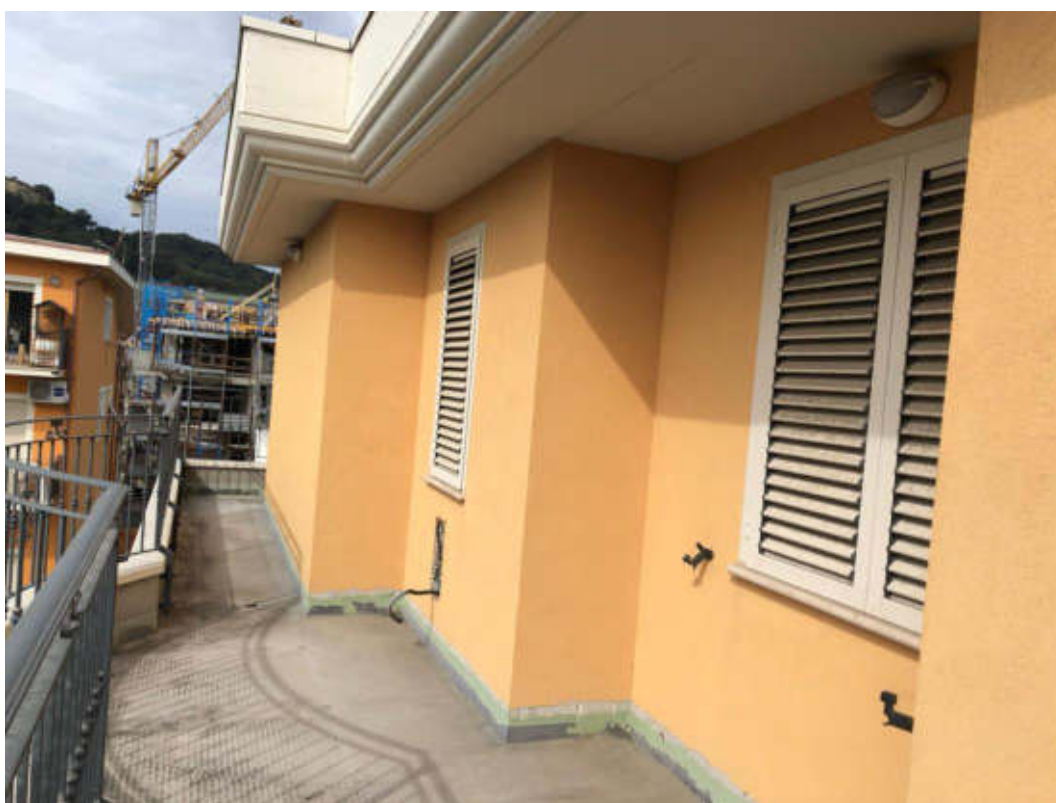
Foto 12: Vista esterna terrazzo al piano terzo
