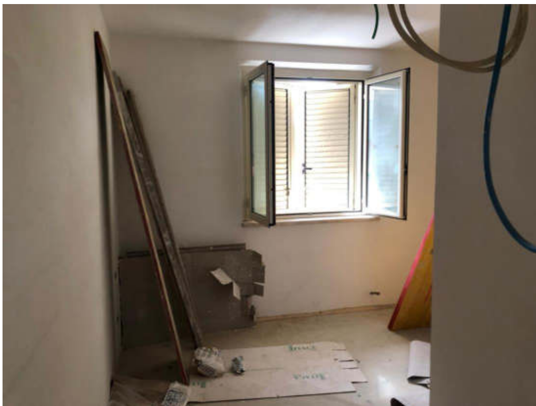
Foto 4: Vista camera al piano secondo
