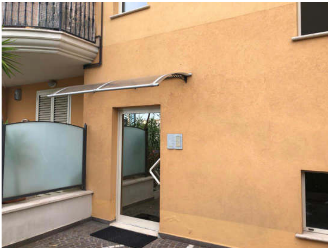
Foto 3: Vista esterna ingresso condominiale
