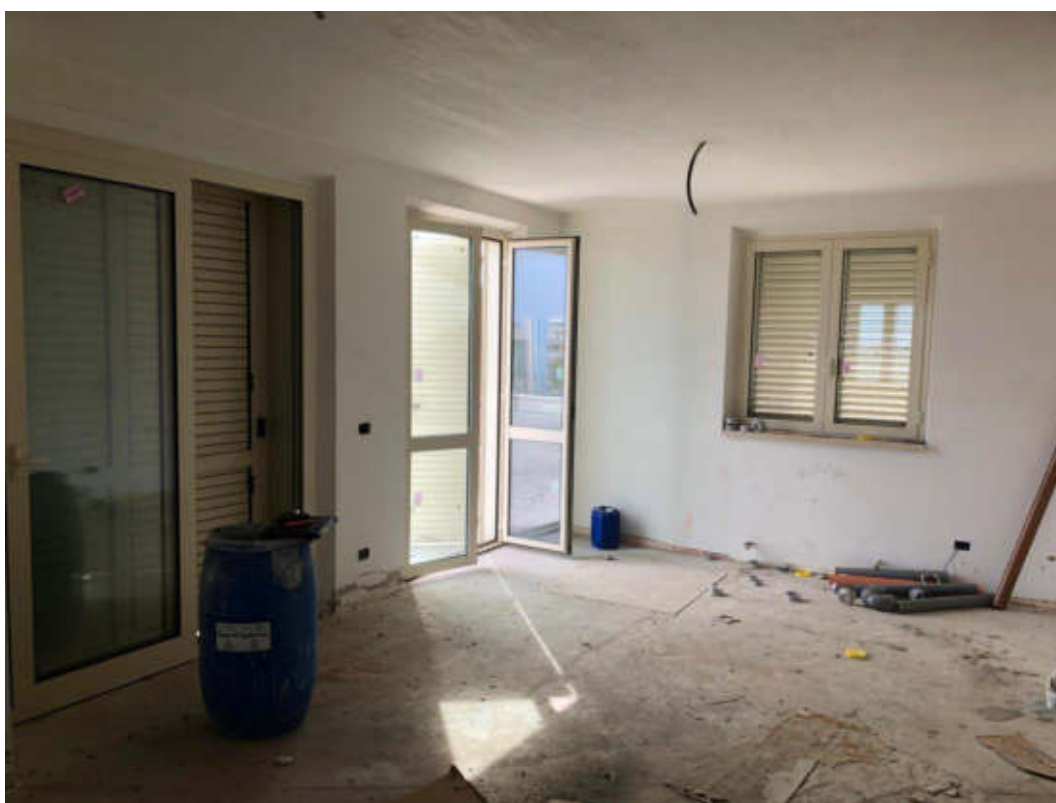
Foto 8: Vista locale pranzo-soggiorno al piano terzo
