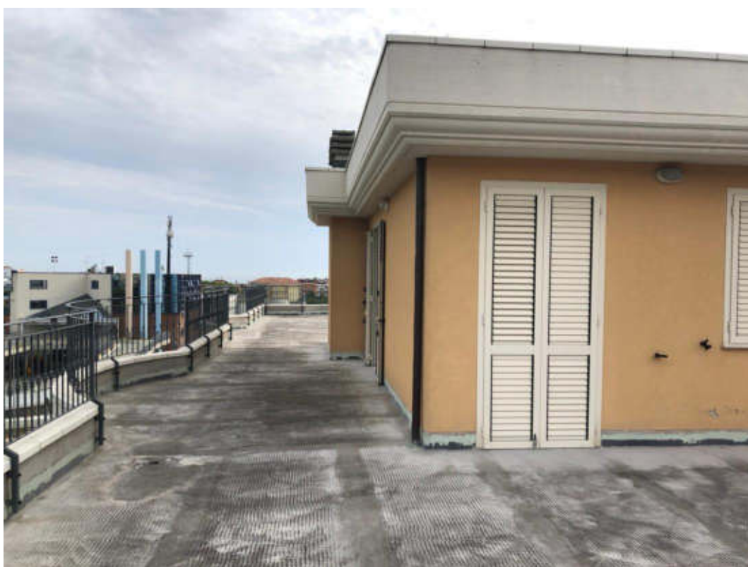
Foto 14: Vista esterna terrazzo al piano terzo
