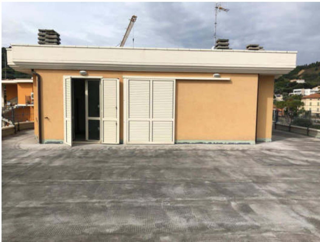
Foto 11: Vista esterna terrazzo al piano terzo
