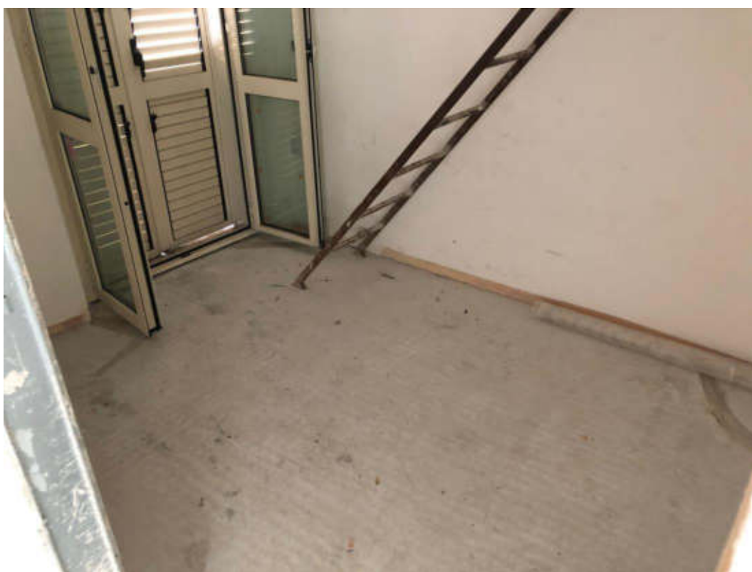
Foto 10: Vista camera al piano terzo
