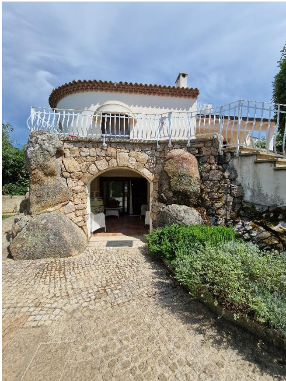
Veranda con accesso alla cantina e al locale tecnico
