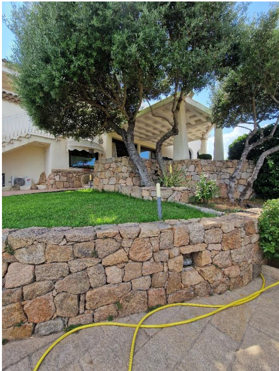
Vista abitazione dal lato veranda
