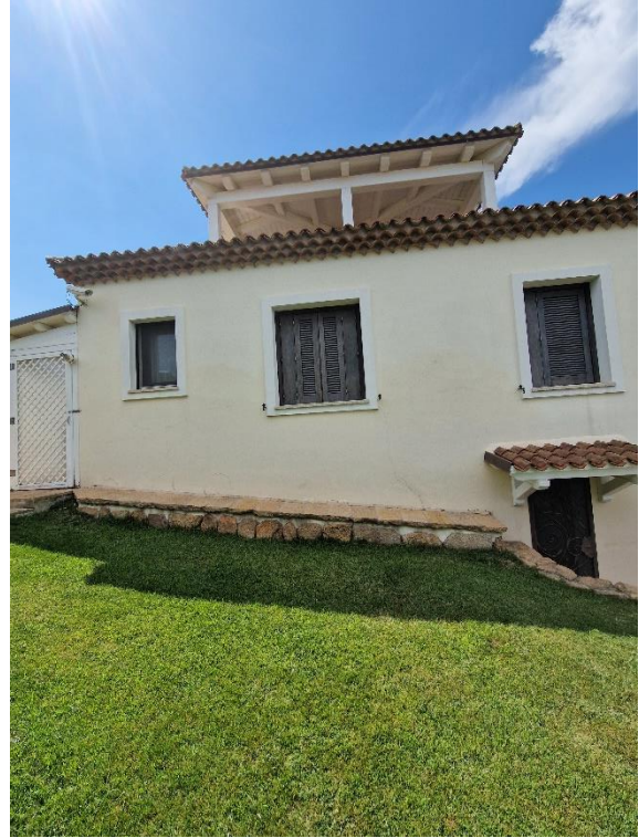
Ingresso del seminterrato lato lavanderia
