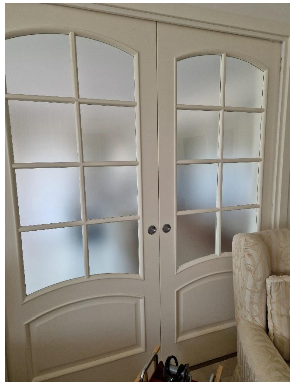
Porta di collegamento soggiorno e pranzo
