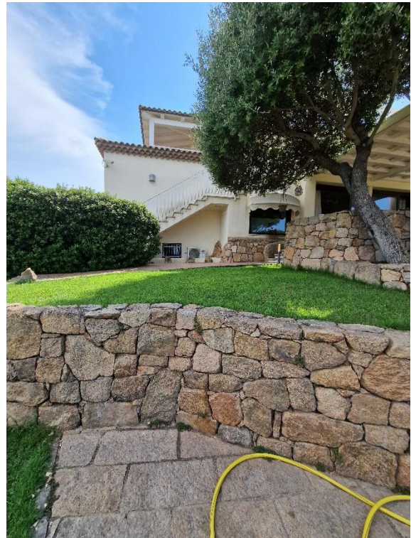
Vista scala di accesso al sub 5
