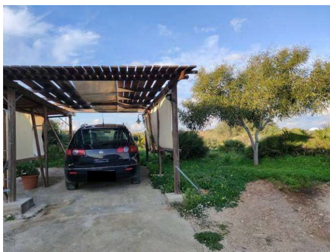
Foto 12. Struttura precaria insistente sulla p.lla 519
