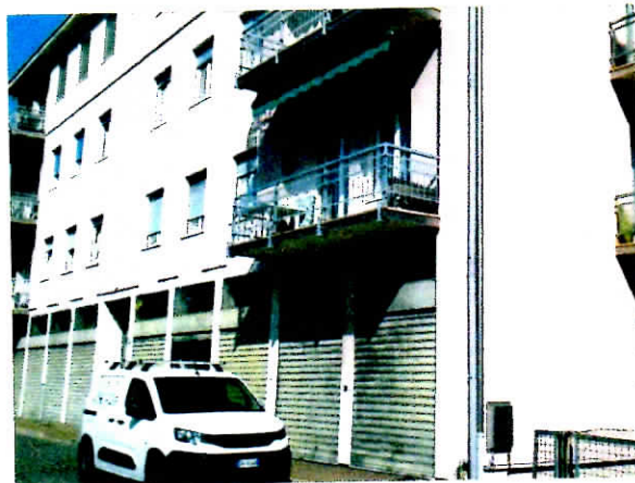
Facciata verso Via Vertua Gentile
