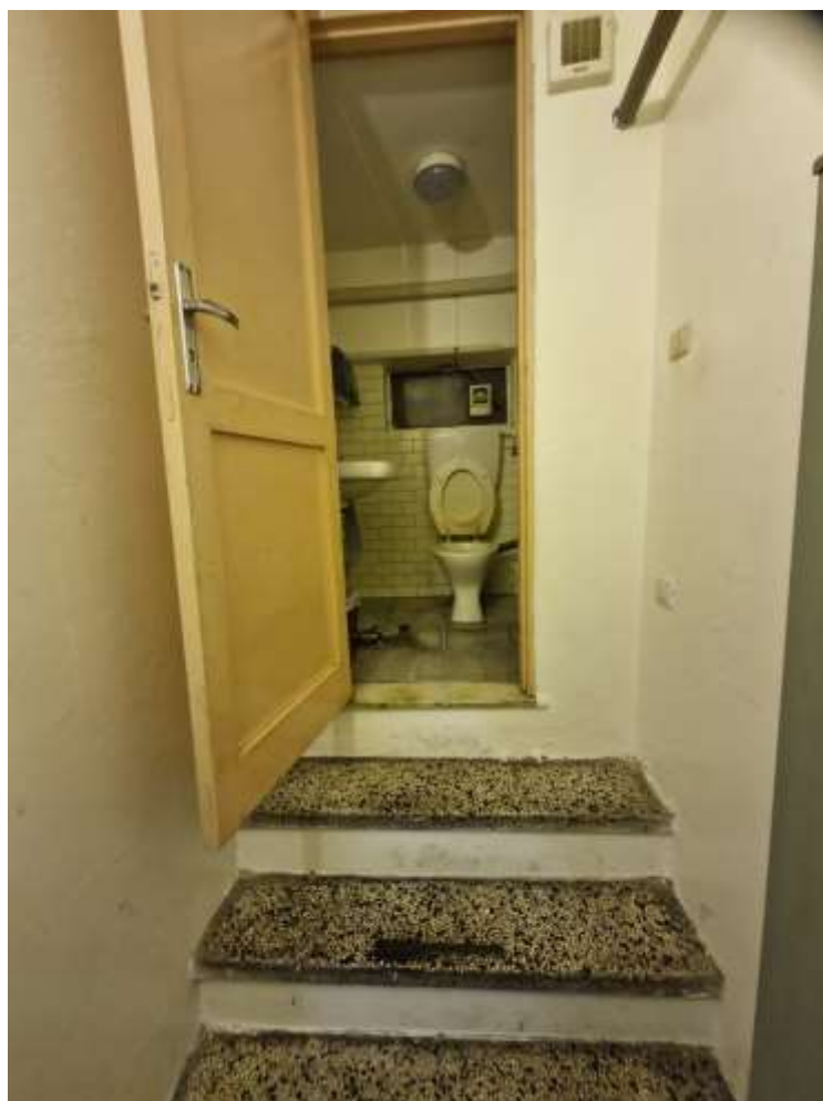
FOTO 8 –WC al piano interrato
