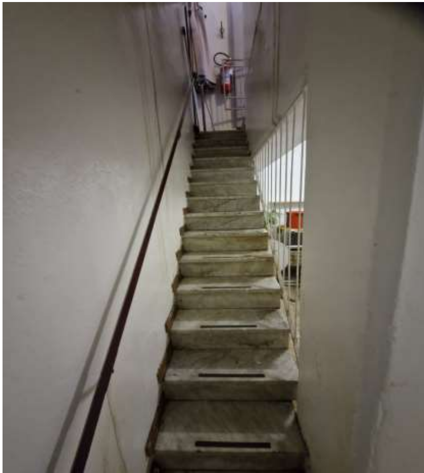
FOTO 5 – Scala di accesso al 1° piano interrato
