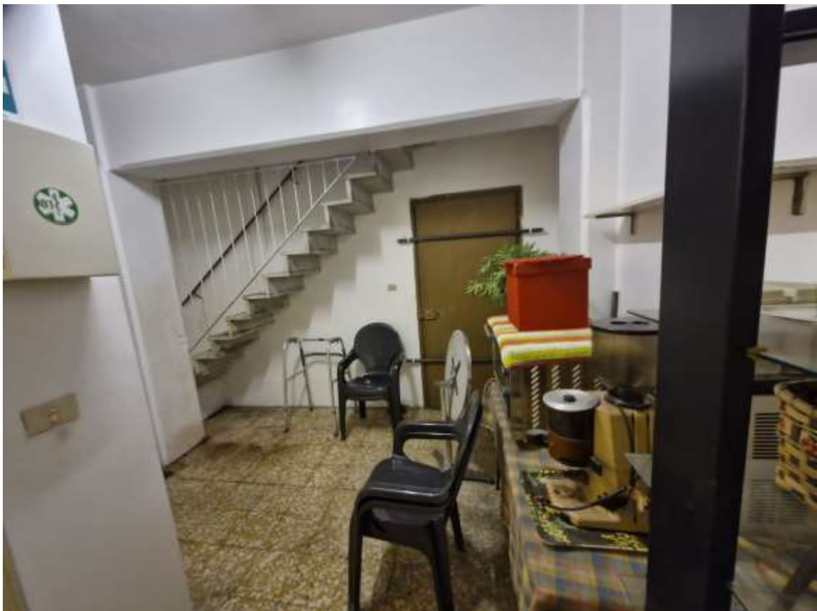
FOTO 6 – Locale al 1° piano interrato
