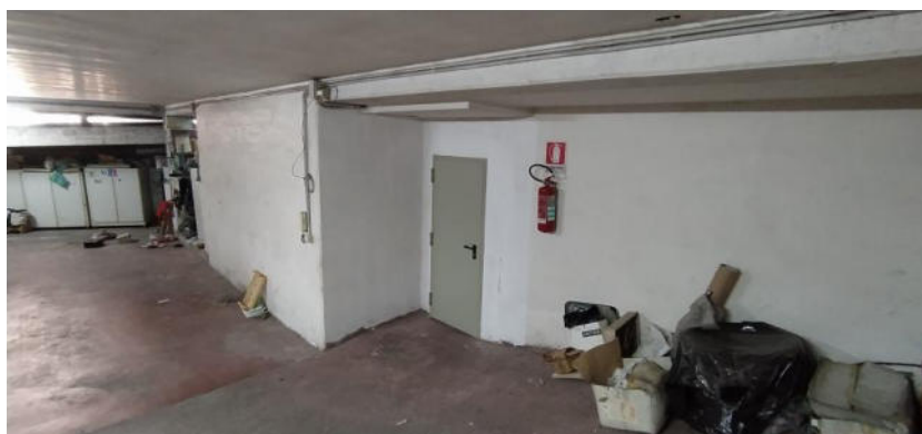
Porta antincendio d'accesso al disimpegno del vano ascensore
