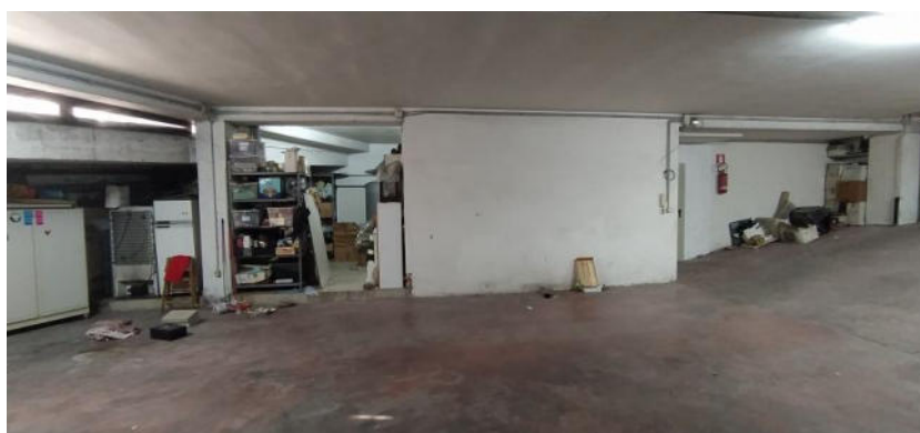
Interno del locale con finestrelle sulla via Brindisi
