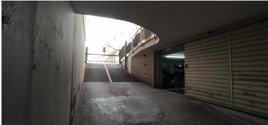
Rampa che conduce al piano interrato e cancello d'accesso al locale
