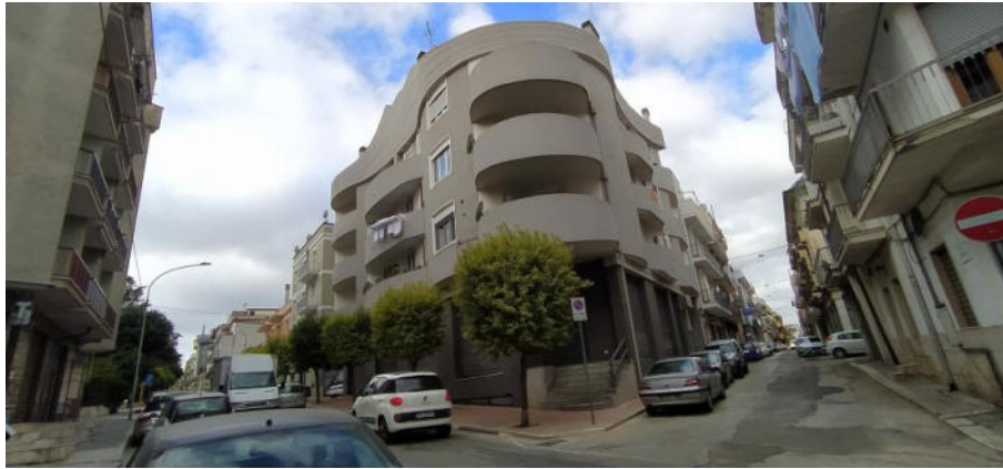
Vista della palazzina di cui l'immobile in esame fa parte posta ad angolo tra la Via Brindisi e la Via Cassano delle Murge
