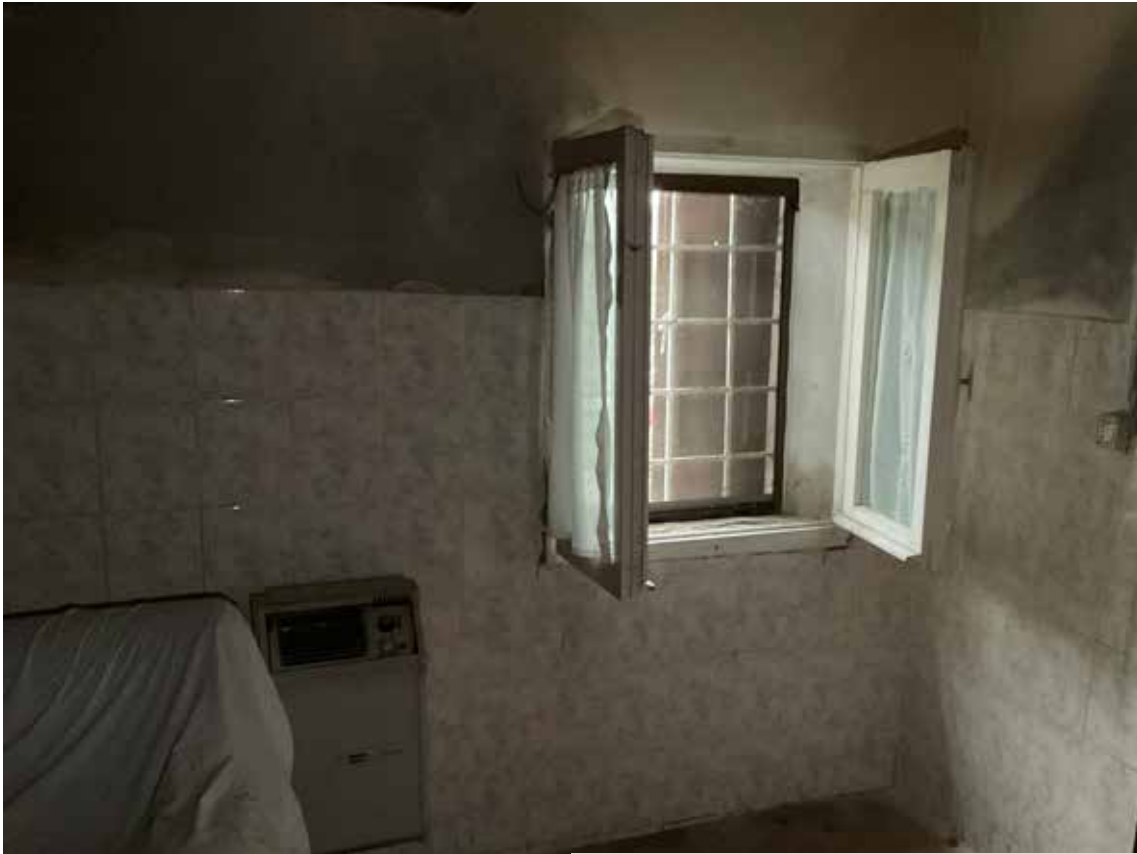
foto 07 - vista interna abitazione piano terra
