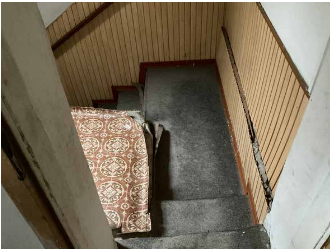
foto 11-vista interna abitazione piano secondo
