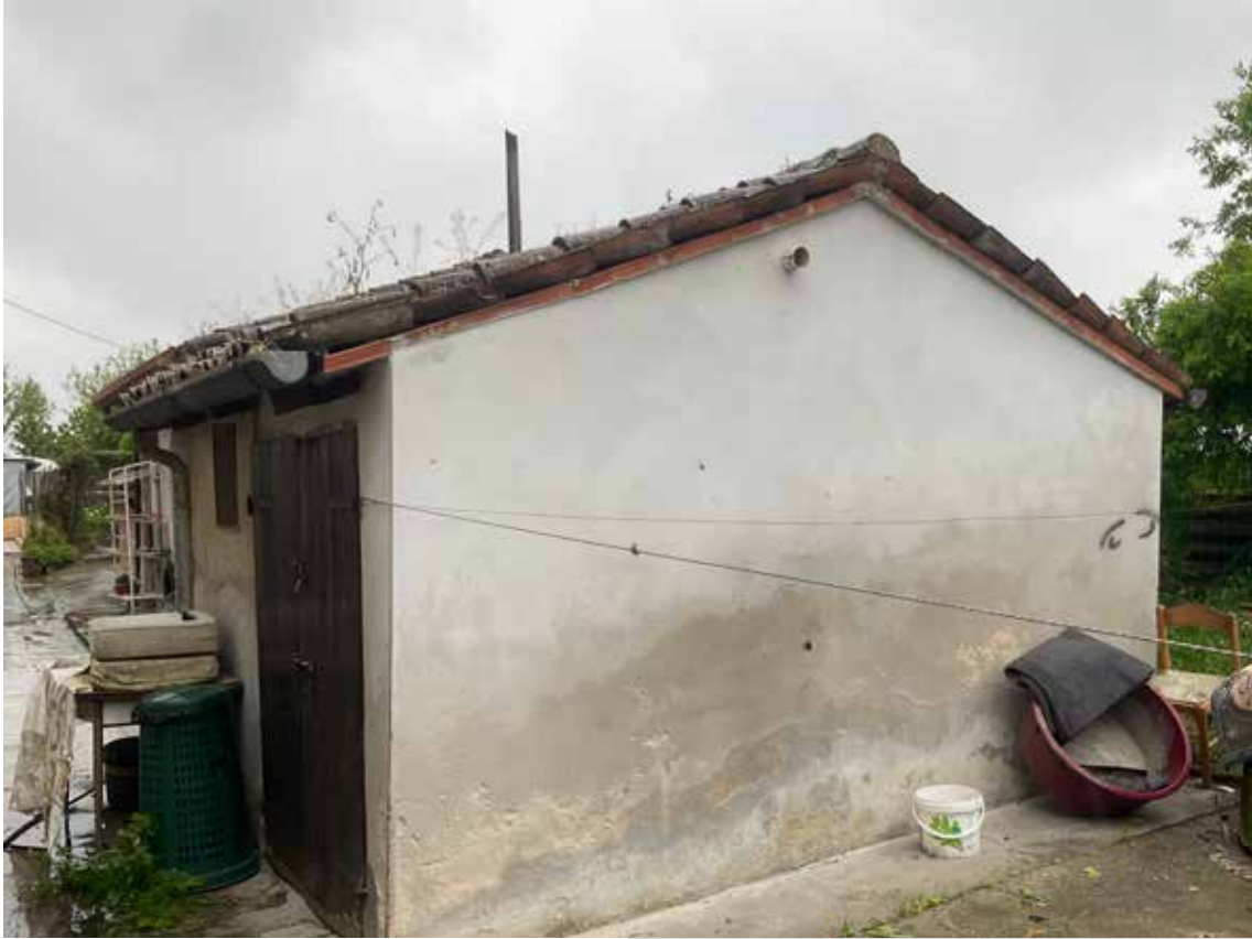
foto 03 - vista esterna rustico
