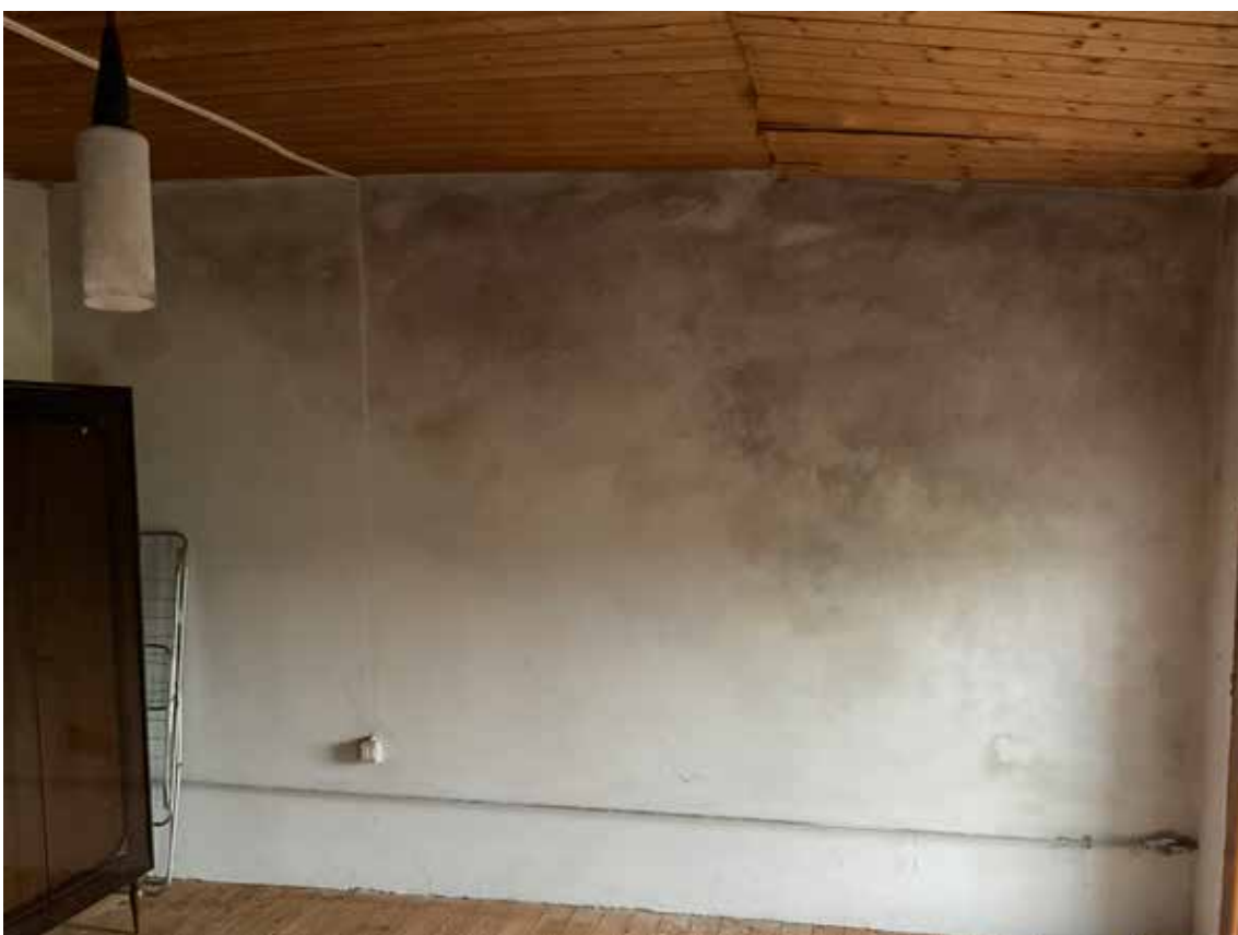
foto 12-vista interna abitazione piano secondo
