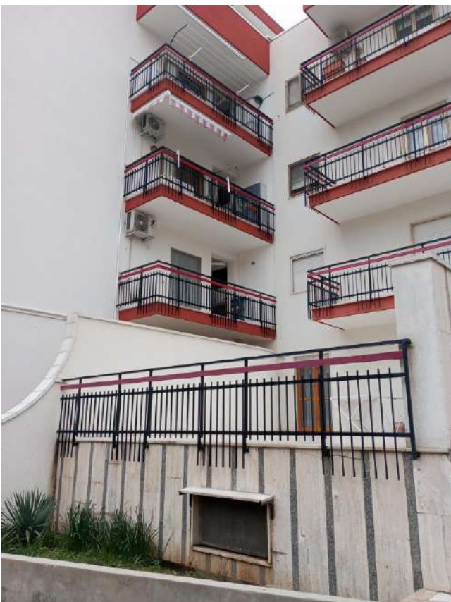
Foto n. 2: vista su via Lama di Grazia – facciata esposta a Sud
