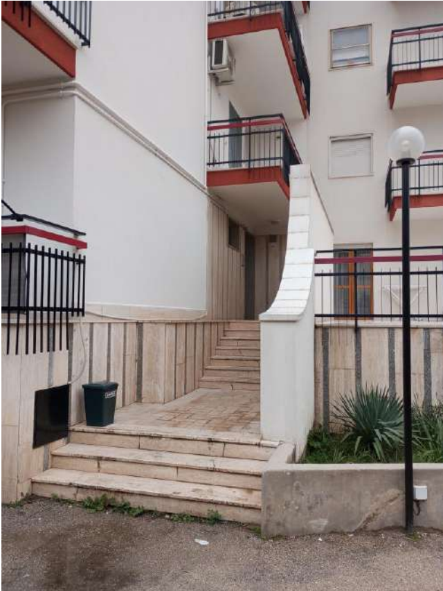
Foto n. 1: vista su via Lama di Grazia (scala esterna di accesso al fabbricato – civico 6/B)
