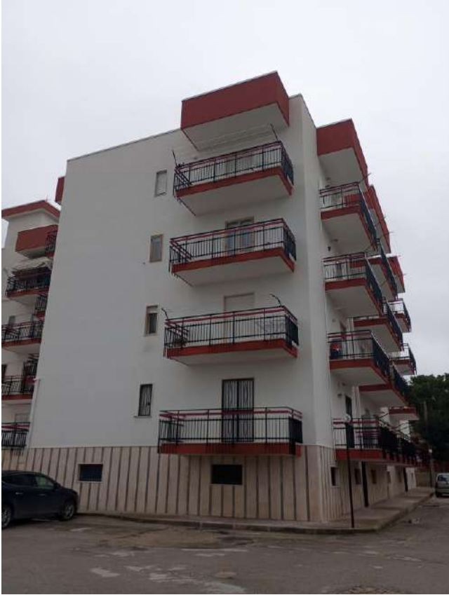
Foto n. 3: vista su via Lama di Grazia – facciata esposta a Nord
