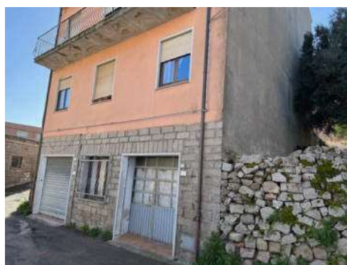
Ingressi da via Risorgimento
