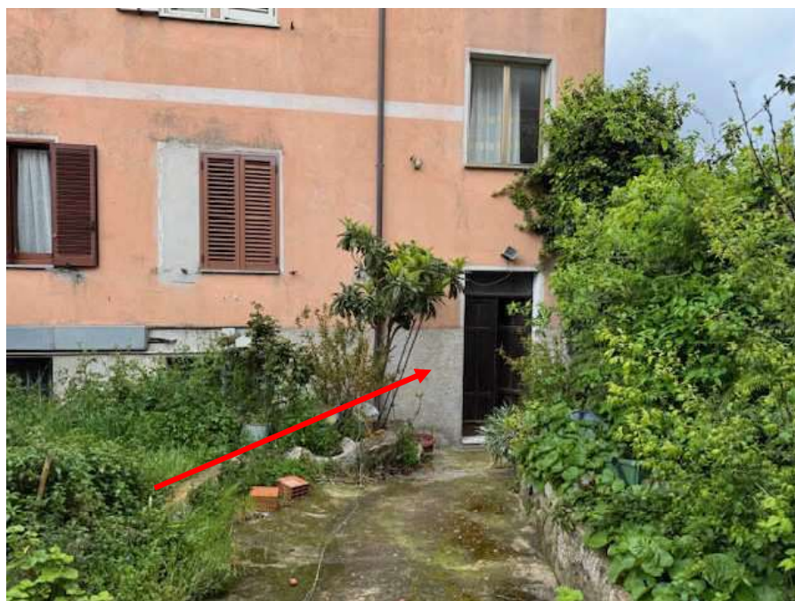
Vista INGRESSO POSTERIORE DAL LOTTO PERTINENZIALE
