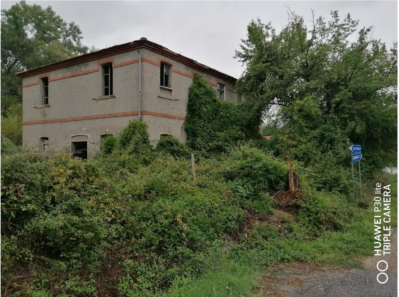
EDIFICIO VOC. COLTRONARA II
