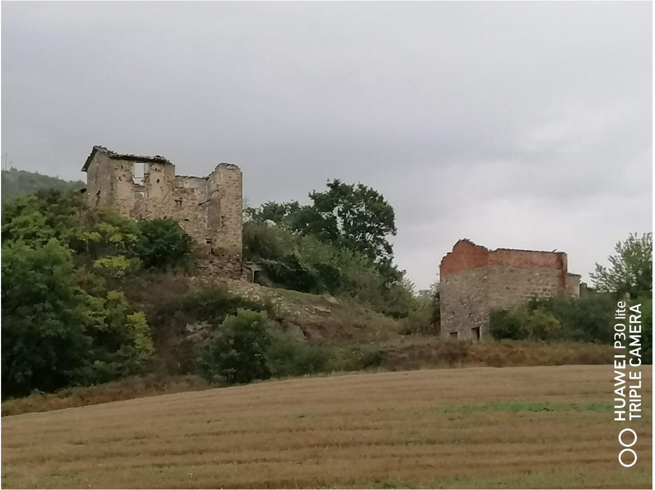
EDIFICIO VOC. CASELLA
