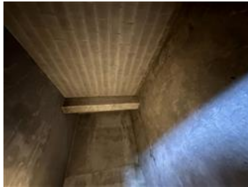
Particolare interno: locale deposito - magazzino
