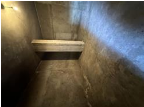
Particolare interno: locale deposito - magazzino
