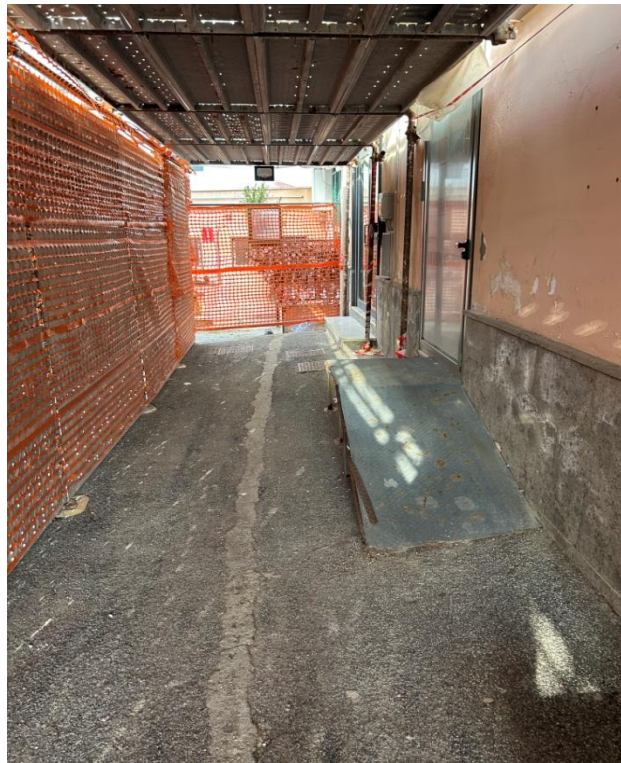
Foto n. 3 – Viale d'accesso al fabbricato in cui è ubicato l'immobile pignorato
