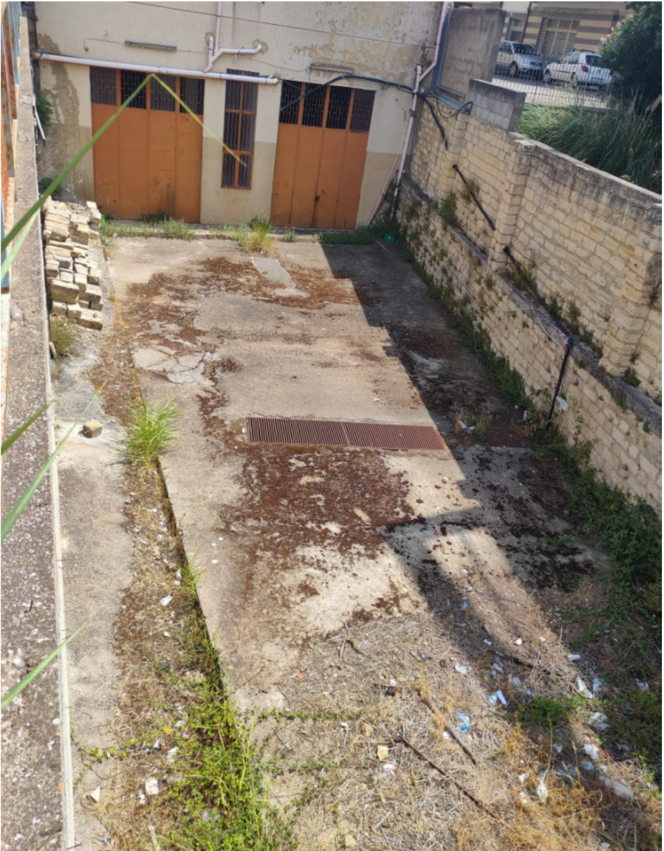
Vista piazzale dei magazzini da Via Mario Lo Piccolo
