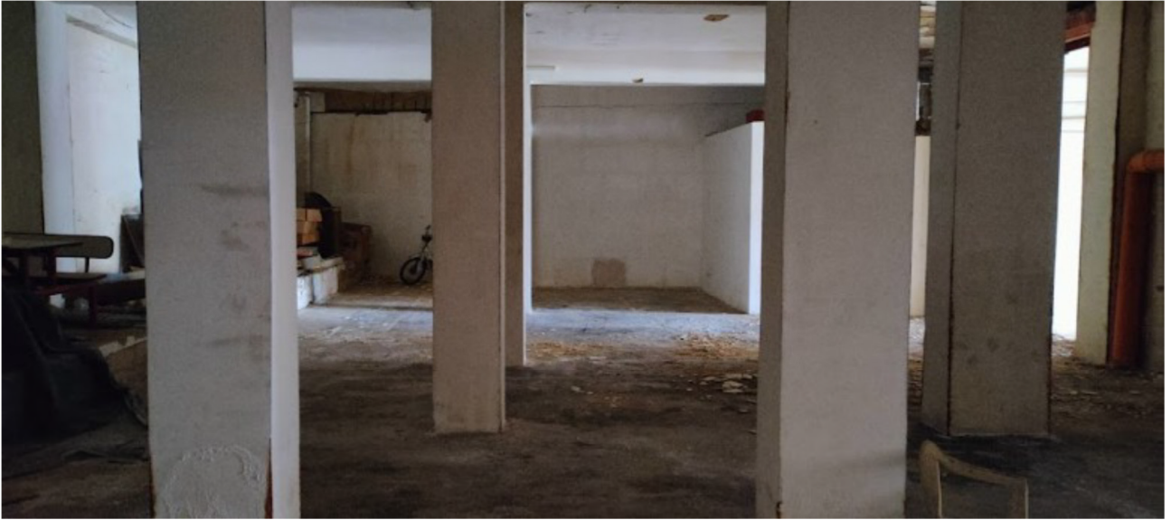
Vista esterna locali servizi a piano sottostrada (part. 2745 sub. 16)
