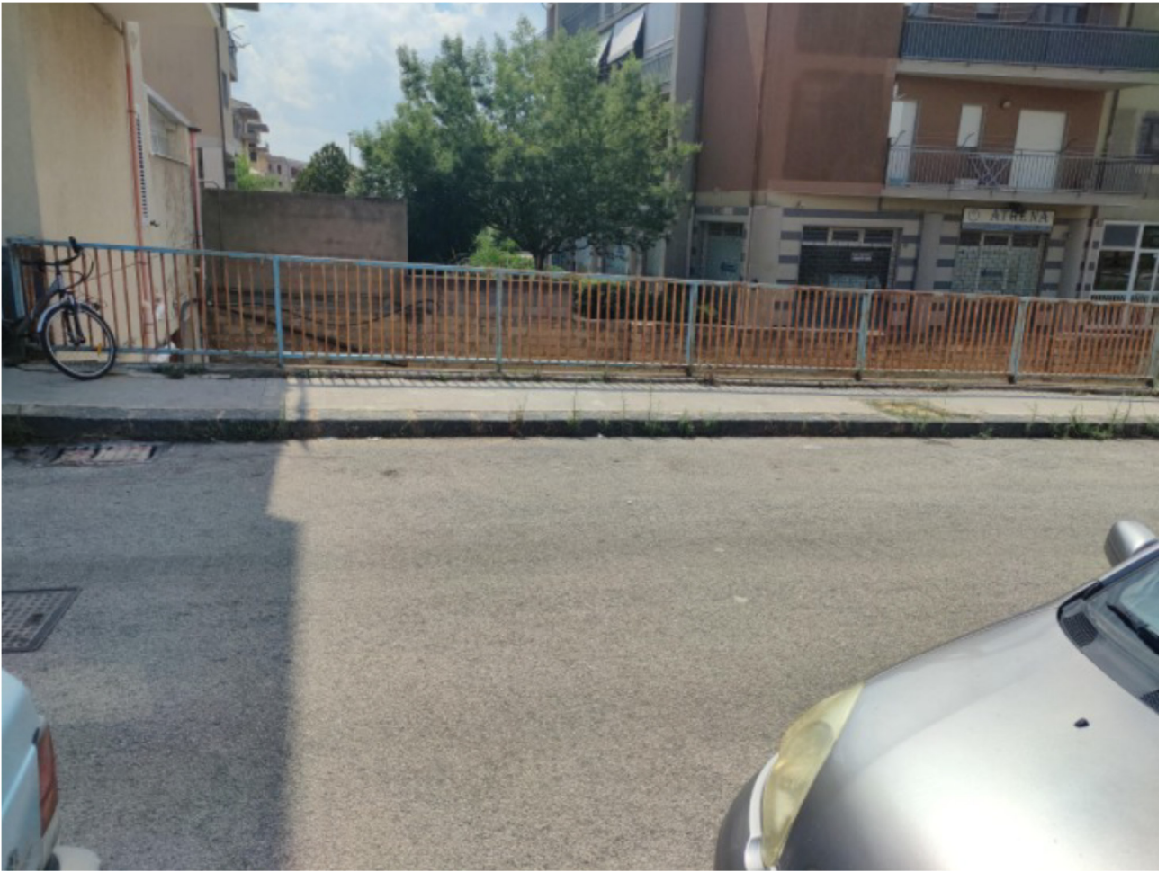
Panoramica edificio in Via Mario Lo Piccolo
