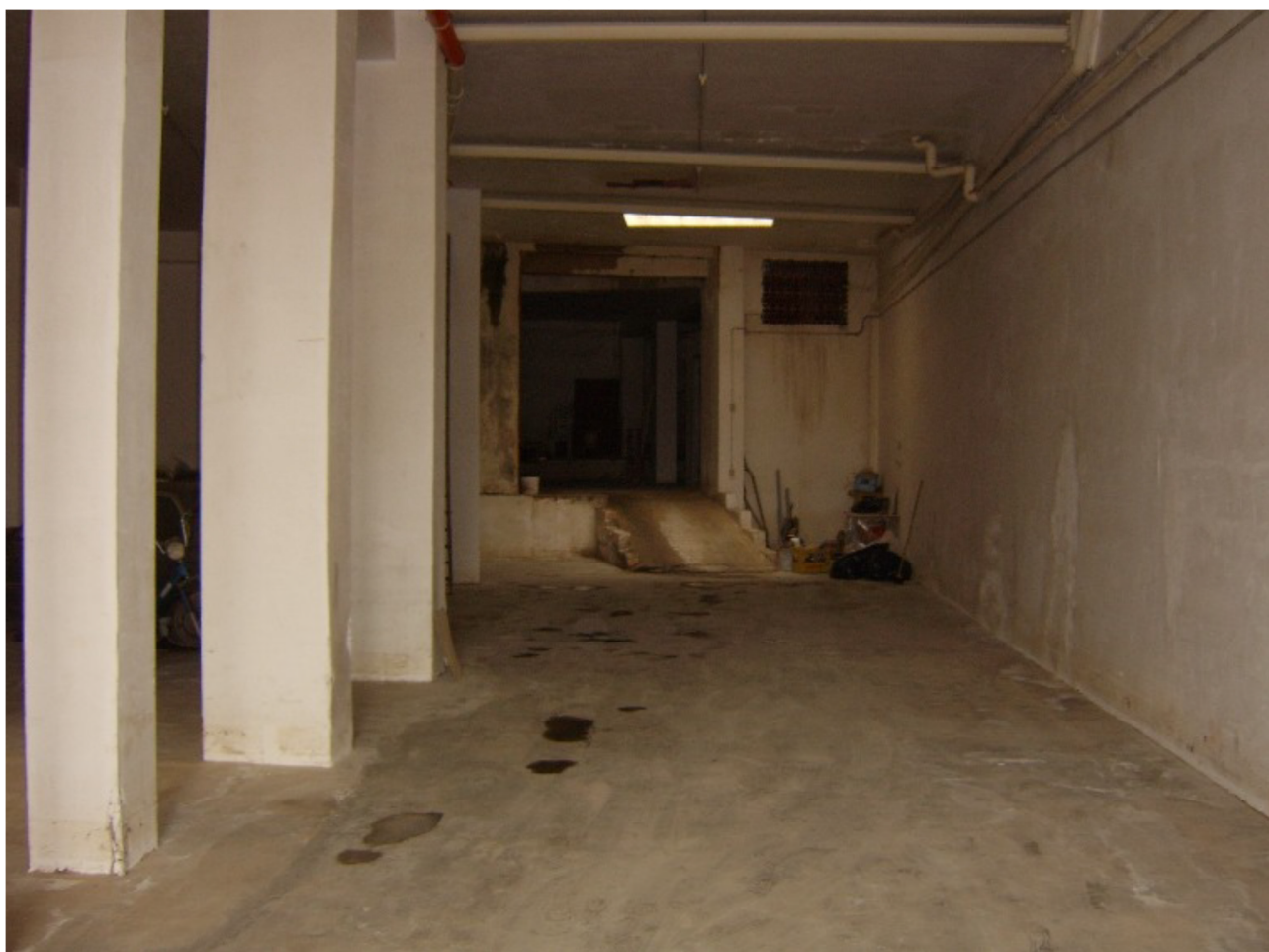
Vista interna Magazzino a piano sottostrada (part. 2394 sub. 7)
