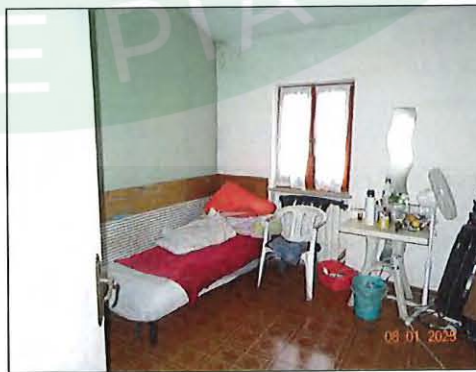
Foto 9 - Unità sub 8 piano primo
