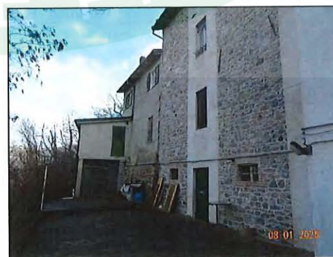
Foto 5 – Retro fabbricato prospetto ovest
