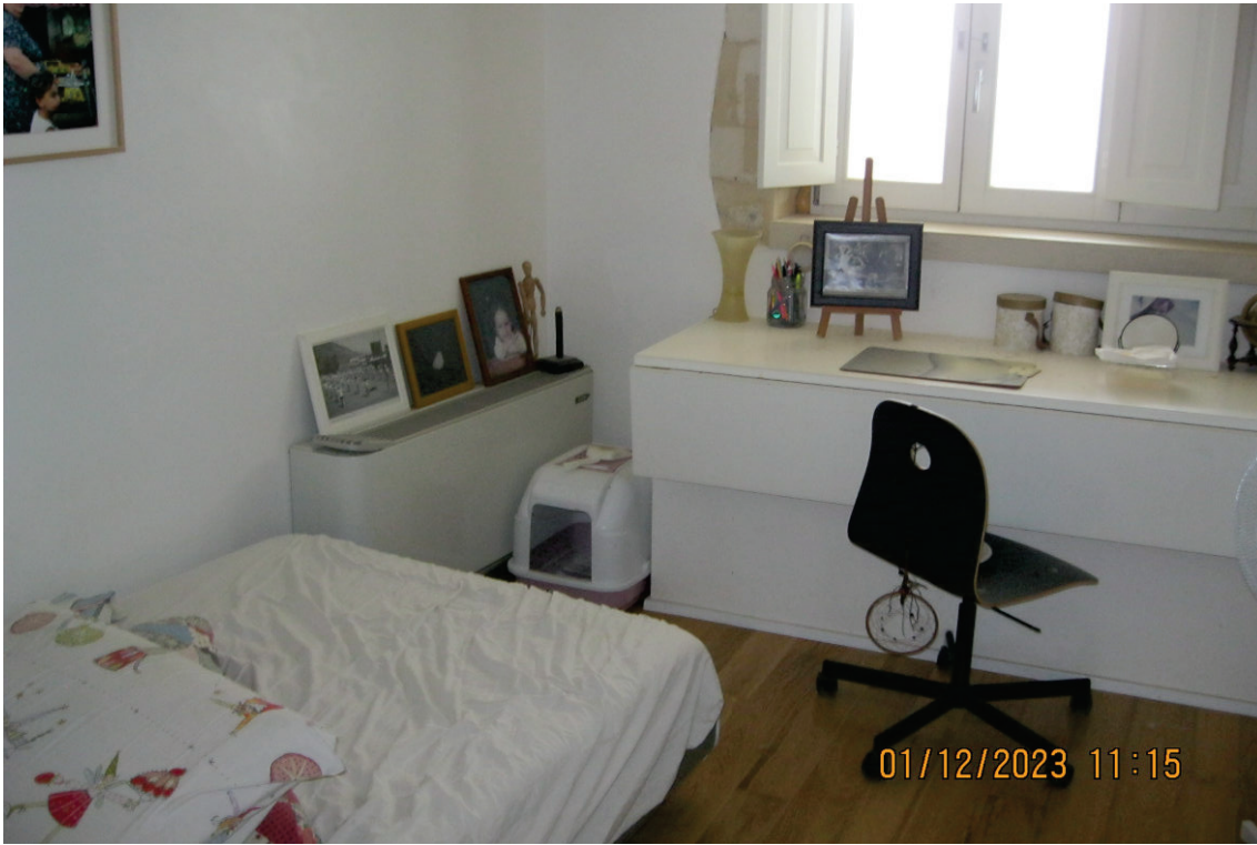
Foto 33: il piano soppalcato, urbanisticamente assentito come locale di sgombero
