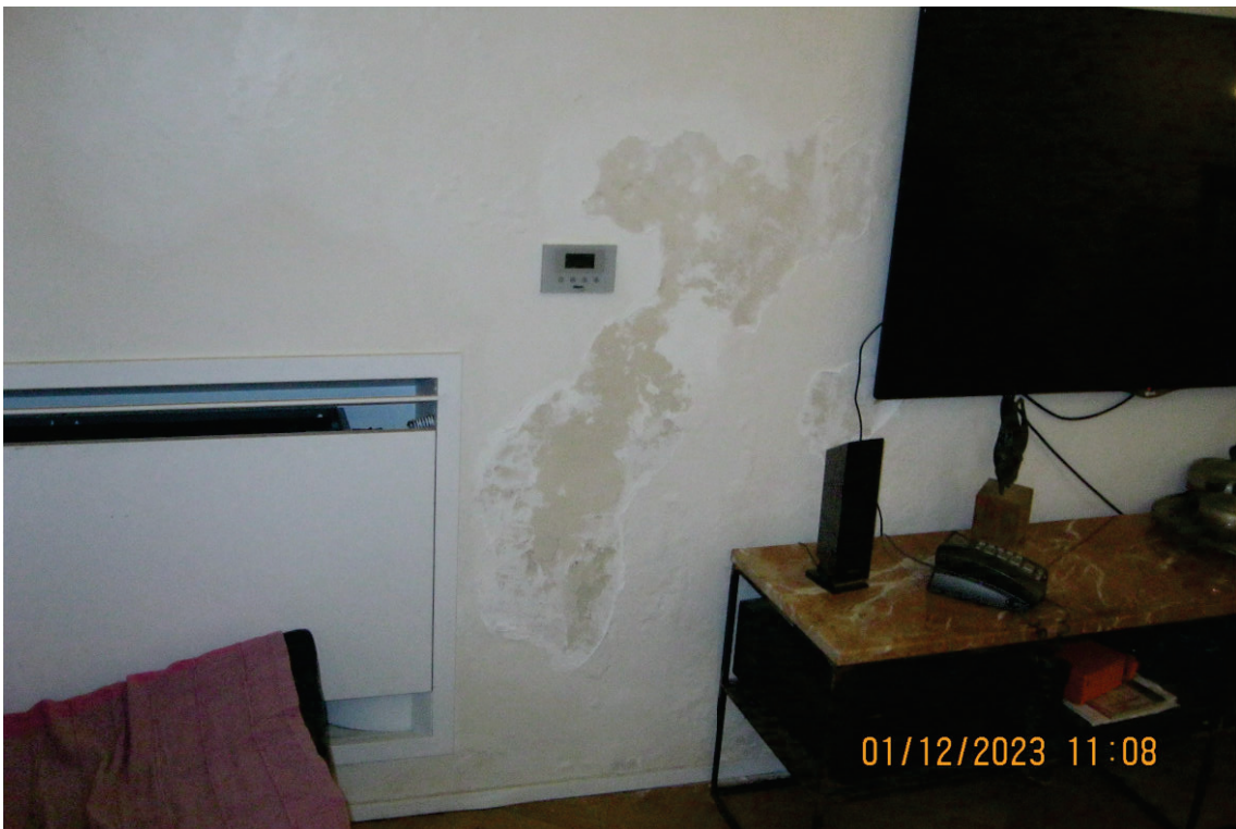
Foto 22: particolare dell'umido presente nel vano a zona giorno
