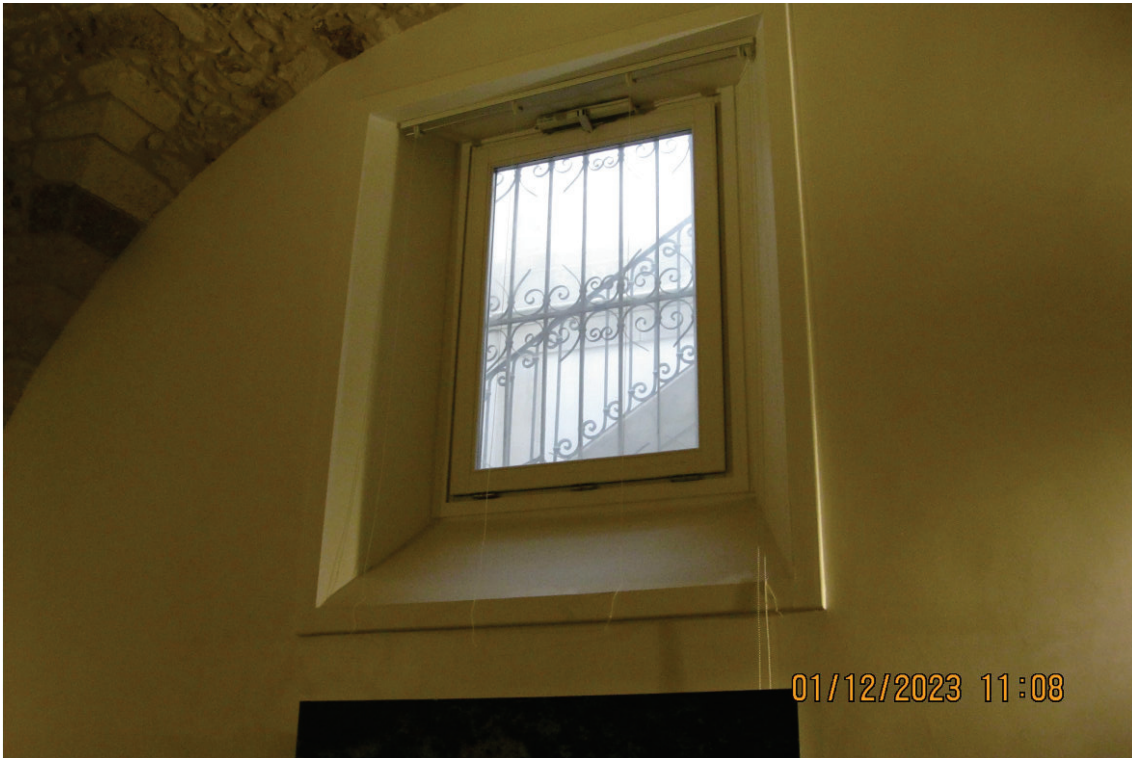
Foto 23: la finestra presente immediatamente al di sotto del soffitto a volta
