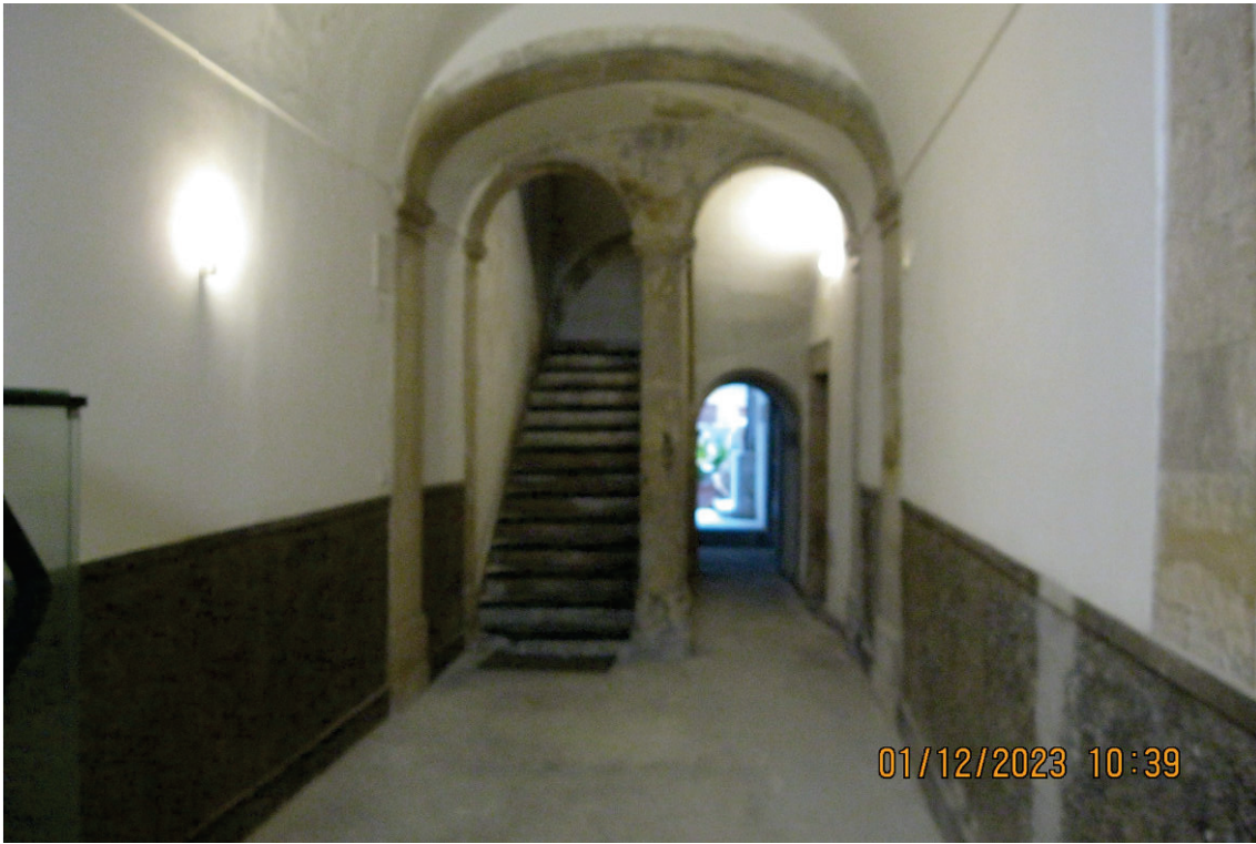
Foto 5: altra rappresentazione fotografica dell'androne di ingresso
