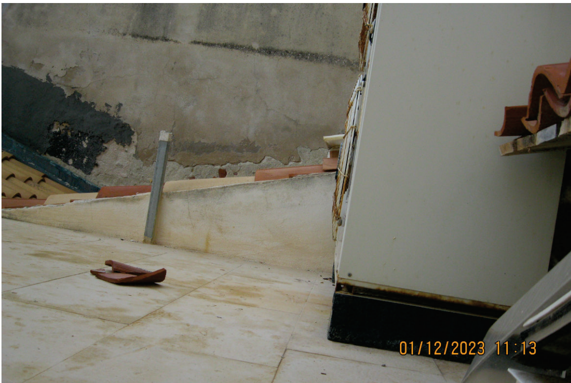
Foto 38: il lastrico solare con funzione di area tecnica
