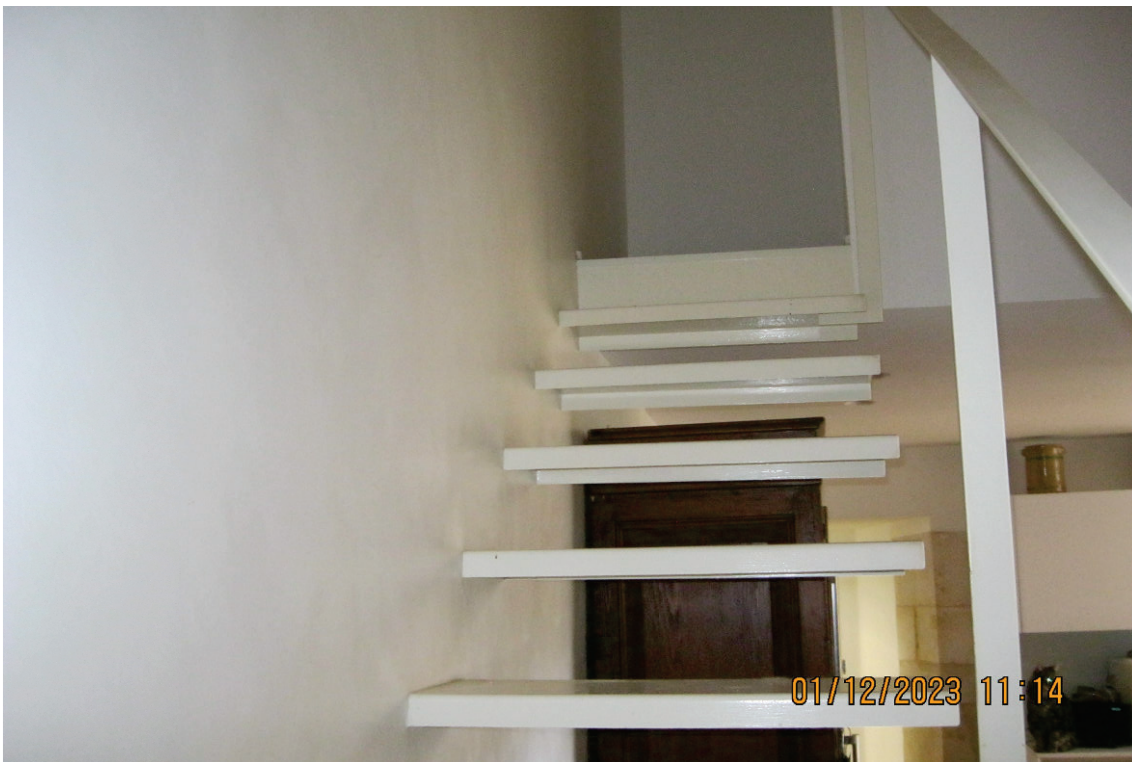
Foto 32: la scala di accesso al piano soppalcato
