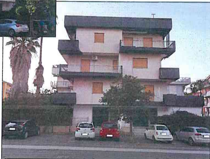
Foto 4-5 - Vista dell'immobile oggetto di stima prima e dopo la messa in sicurezza con rete. L'edificio si compone di piano interrato garage, piano terra/rialzato locale commerciale, 1°, 2°, 3° piano abitativi e copertura a terrazza. In particolare tutti i balconi e il cornicione necessitano di lavori di manutenzione straordinaria.
