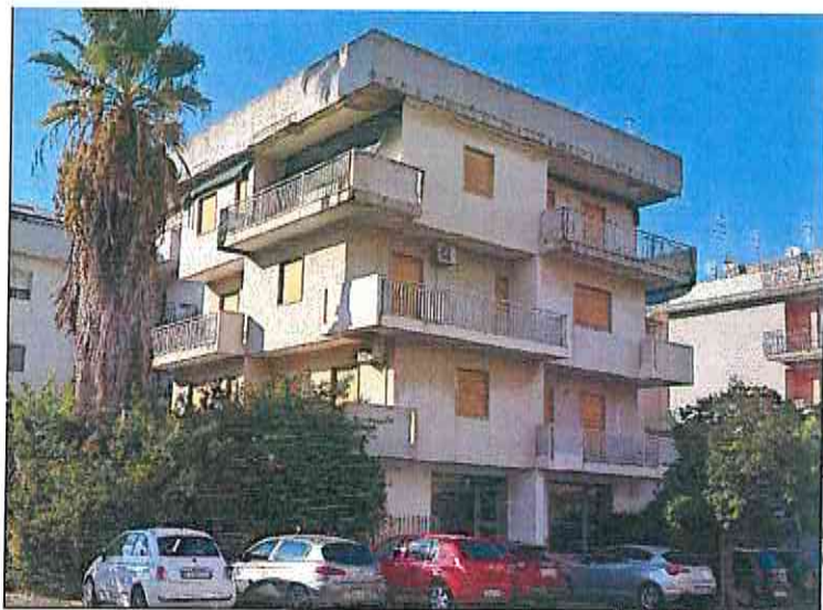
Foto 4-5 - Vista dell'immobile oggetto di stima prima e dopo la messa in sicurezza con rete. L'edificio si compone di piano interrato garage, piano terra/rialzato locale commerciale, 1°, 2°, 3° piano abitativi e copertura a terrazza. In particolare tutti i balconi e il cornicione necessitano di lavori di manutenzione straordinaria.
