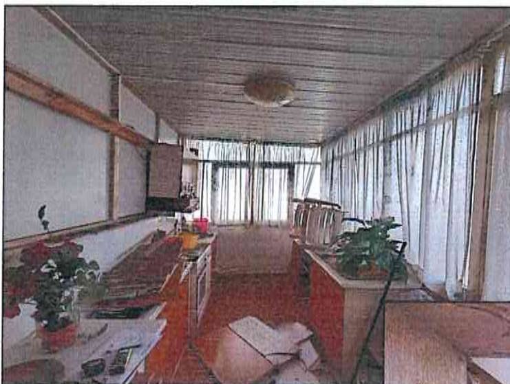
Foto 25-26 - Foto della veranda coperta destinata a cucina, sanabile con Cila tardiva e chiudendo l'accesso dall'interno per non creare ulteriore volumetria (non sanabile). L'involucro è in acciaio e vetro con soprastante termocopertura. Vista dell'accesso esterno dalla terrazza alla veranda-cucina.
