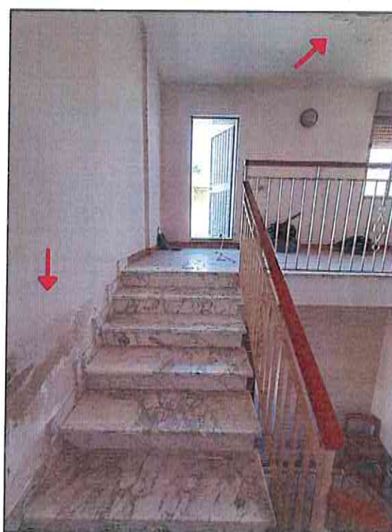
Foto 46-47 - Foto del wc 1 di piccole dimensioni. Vista del vano scala di accesso alla terrazza di copertura con evidente degrado di umidità.
